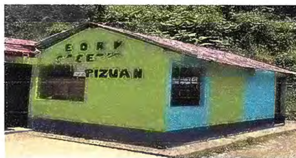
Foto 6: MODULO 2: SUSTITUCIÓN DE LÁMINA
