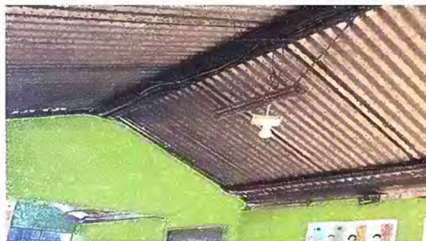
Foto5: MODULO 1: SUSTITUCIÓN DE LÁMPARAS
