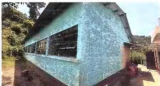
Foto 3: MODULO 1 : PINTURA EN MUROS EXTERIORES E INTERIORES
