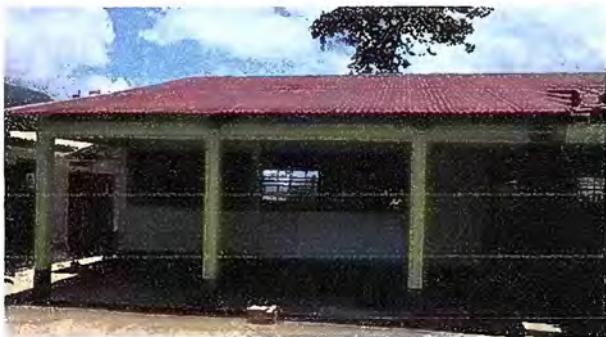
Foto1: MODULO 1: SUSTITUCIÓN DE LÁMINA
