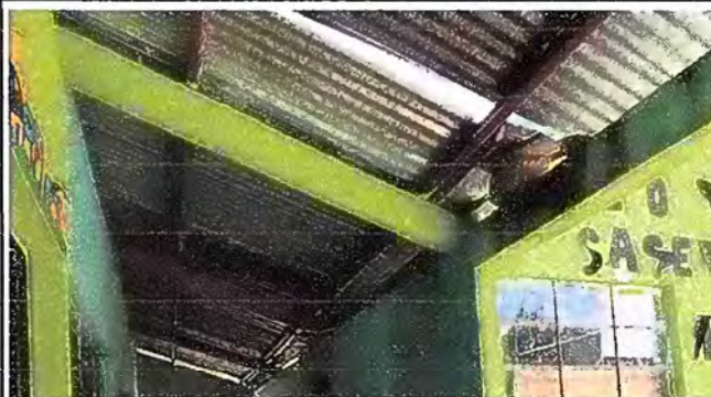
Foto 2: MODULO 1: SUSTITUCION DE CANAL
