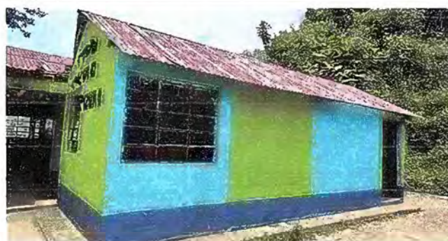
Foto 8: MODULO 2: PINTURA EN MUROS EXTERIORES E INTERIORES
