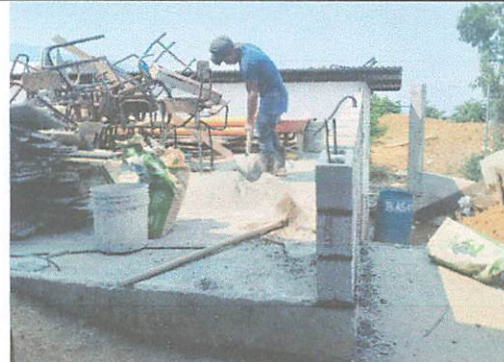
Foto 2: Durante la remodelación de una pared
