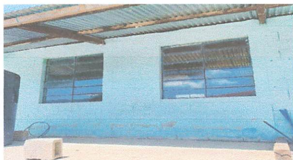
Foto 3: Durante la remodelación de una ventana
