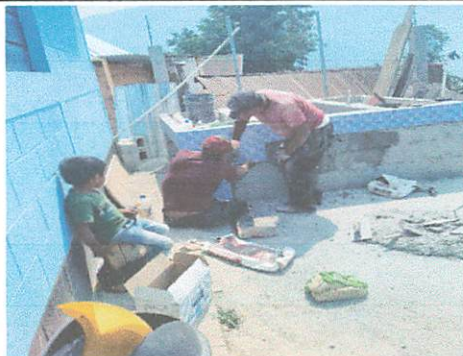
Foto1: Durante remodelación de una pila
