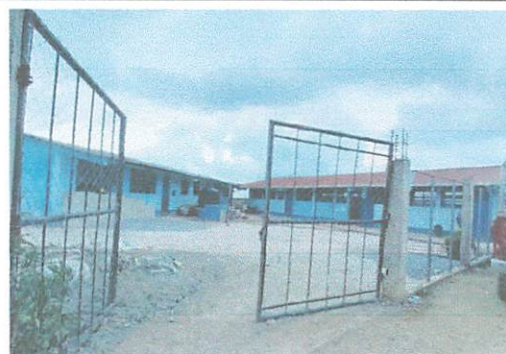
Foto 4: Durante mejoramiento de portón
