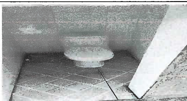
Foto 3: SUSTITUCION DE INODORO CONCLUIDO
