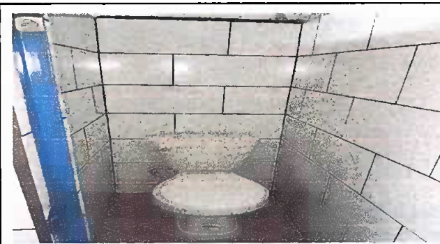
Foto 4: SUSTITUCION DE AZULEJO CONCLUIDO
