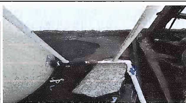
Foto 2: SUSTITUCION DE TUBERIA NPVC LINEA PRINCIPAL AGUAS NEGRAS CONCLUIDO
