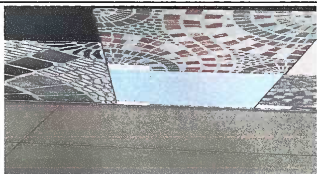
Foto 1: SUSTITUCION DE PISO DE CONCRETO POR PISO ANTIDESLIZANTE CONCLUIDO
