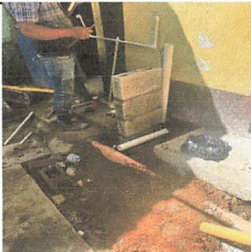
Foto 3: Cambio de Tubo de agua y Drenaje
