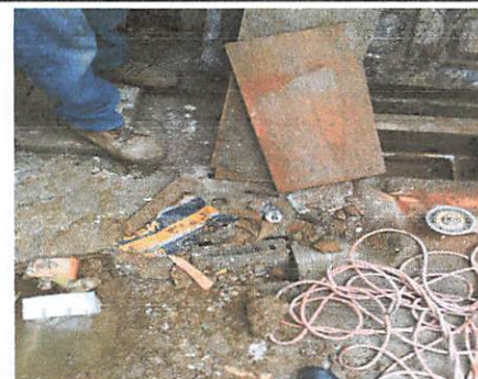
Foto 6: Sustitución de tuberías
