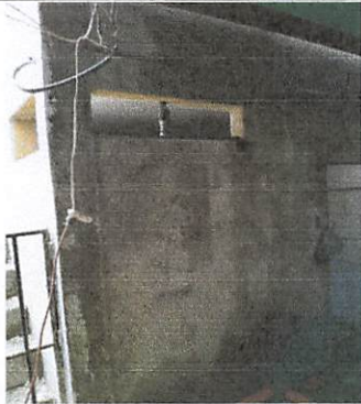
Foto 1: Repello de Muros Exteriores
