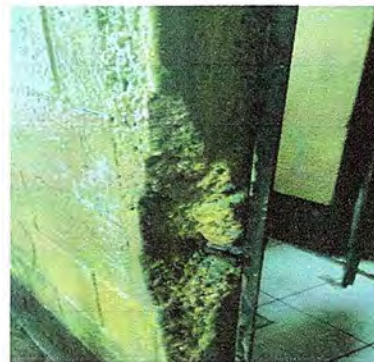
Modulo 8: mantenimiento de pared con repello
