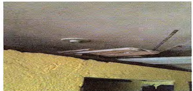
Modulo 6: Sustitucion de Plafonera
