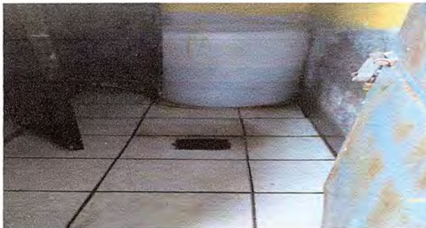
Modlo 5: Sustitucion de Deposito de agua
