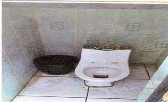
Modulo 3: Sustitucion inodoro
