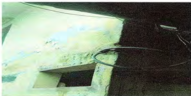
Modulo 7: Reparación de cableado Electrico
