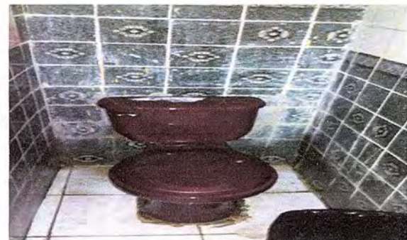
Modulo 4: Sustitucion de azulejos
