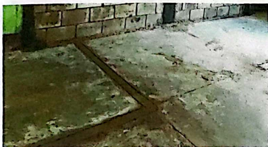
FOTO 3: REPARACION DE PISO DE CEMENTO LIQUIDO
