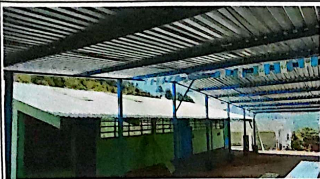
FOTO 1: SUSTITUCION DE LAMINA
