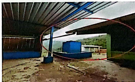
FOTO 4: SUSTITUCION DE CANAL PVC
