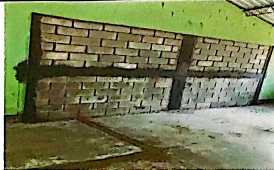
FOTO 2: REPARACION DE MURO
