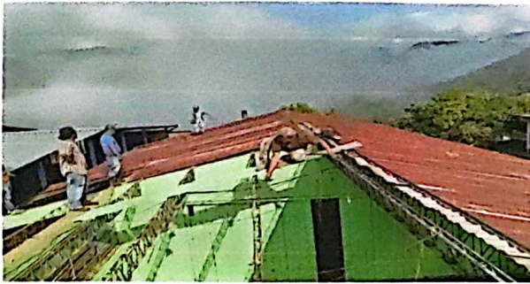
foto 1: sustitucion de lamina
