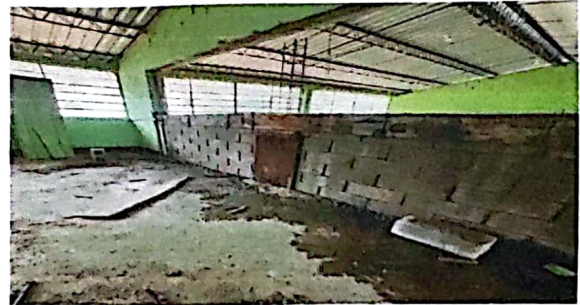
foto 2: reparacion de muro
