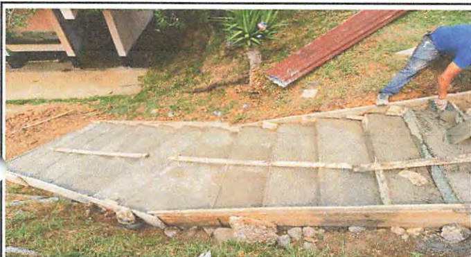
Foto 17: Reparación de gradas.
