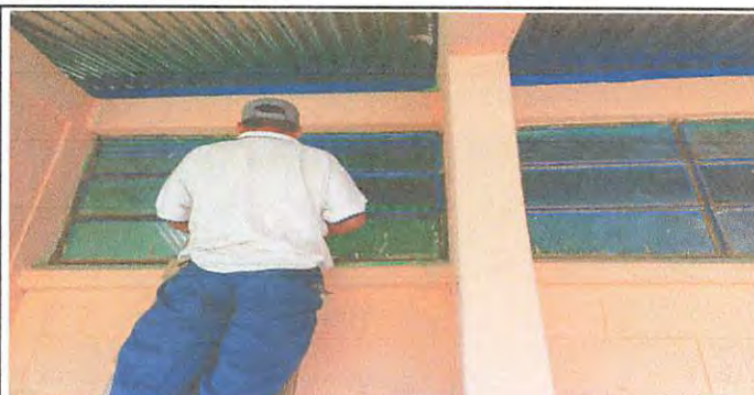
Foto 4: Sustitución de vidrios
