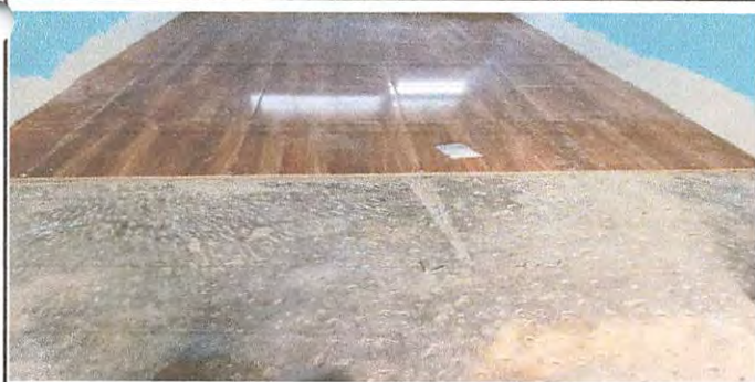
Foto 5: Sustitución de piso cerámico
