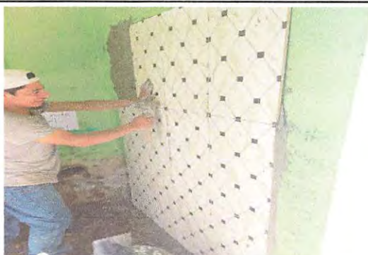
Foto 8: Sustitución de azulejo
