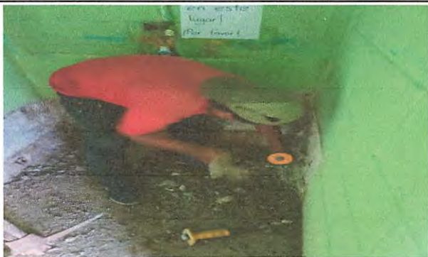
Foto 7: Sustitución de mingitorios
