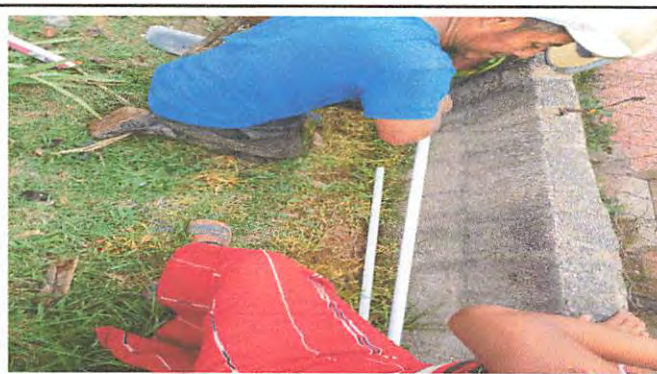
Foto 10: Sustitución de tubería
