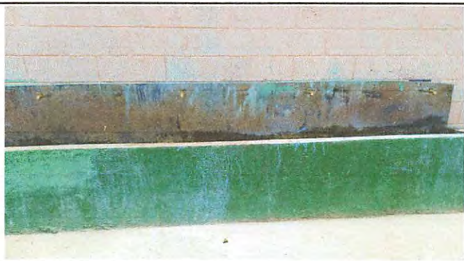
Foto 9: Sustitución de llaves de chorro
