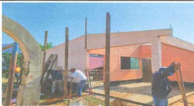
Foto1: Sustitución de lámina por lámina troquelada
