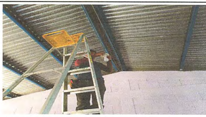
Foto 12: Reparación del sistema eléctrico
