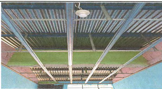
Foto 15: Sustrucción de cielo falso
