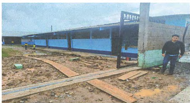
Foto 13: Sustrucción de portón.
