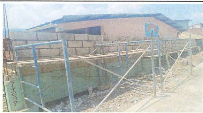
Foto 11: Reparación de muro perimetral.
