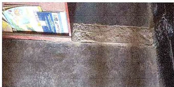
Foto 5: Sustitución de piso cerámico
