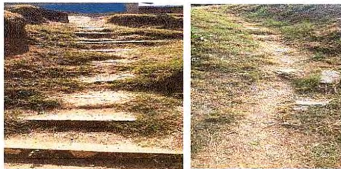
Foto 17: Reparación de gradas.
