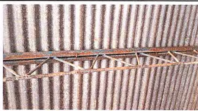
Foto 2: Mantenimiento a estructura de soporte de metal
