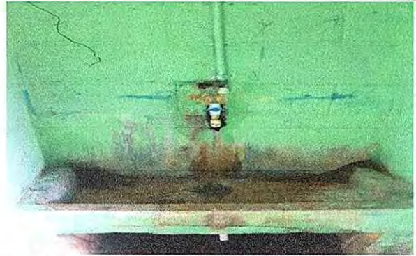
Foto 8: Sustrucción de azulejo
