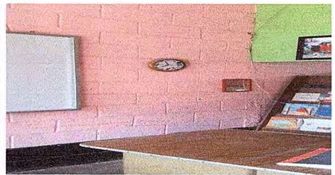
Foto 14: Repello en paredes
