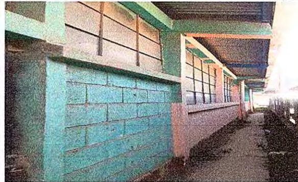
Foto 6: Pintura en paredes interiores y exteriores
