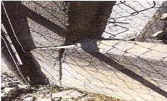
Foto 11: Reparación de muro perimetral.
