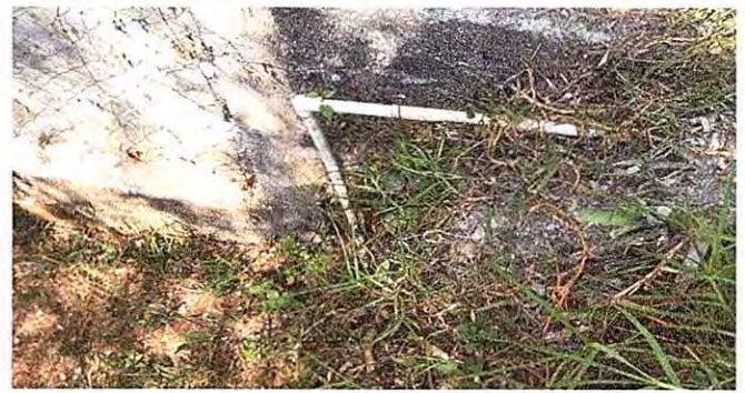
Foto 10: Sustrucción de tubería
