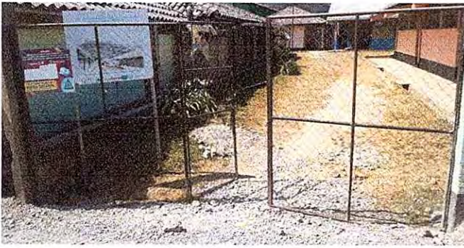
Foto 13: Sustrución de portón.
