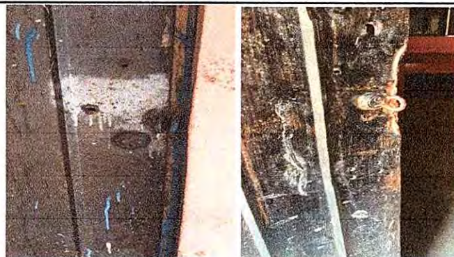
Foto 3: Sustitución de puertas
