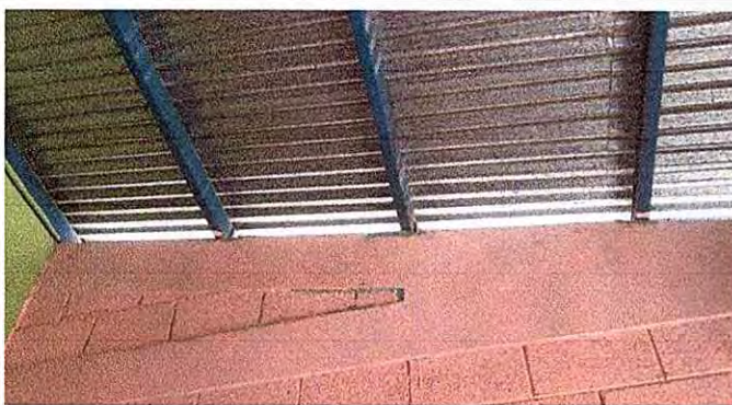
Foto 15: Sustrución de cielo falso
