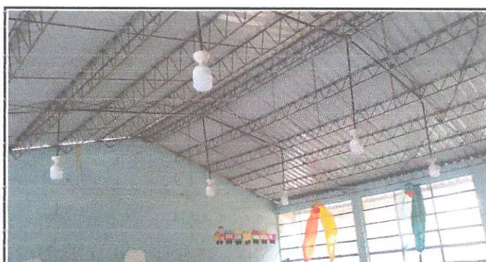
Foto 4: Sustitución de lamparas de 2x40
