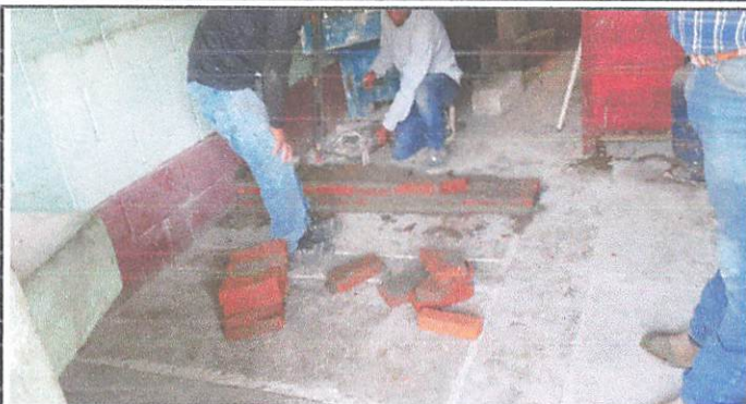
Foto 1 Sustitución de estufa rural (completa) incluye chimenea y plancha de metal.
