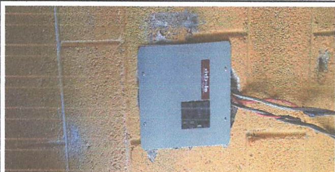
Foto 5: Sustitución de cableado Electrico
