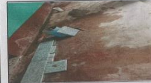
Foto 6: Sustitución de piso
