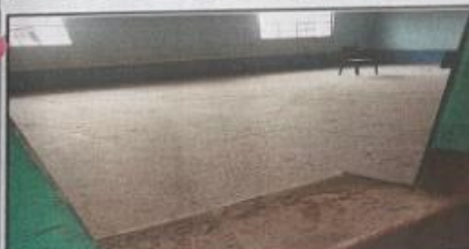
Foto 5: Sustitución de piso
