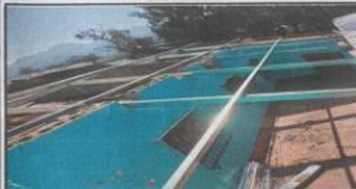
Foto 3: Sustitución de estructura portante de madera por metal
