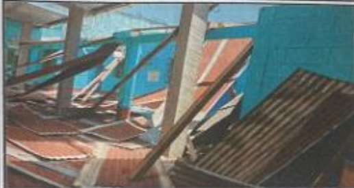
Foto 1: Sustitución de lámina por lámina troquelada
