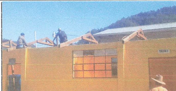
Foto 1: sustitución de estructura de soporte de madera, por metal M2
