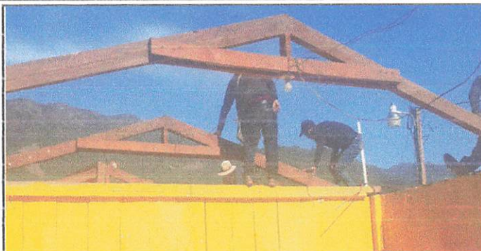
Foto 2: Sustitución de estructura de soporte de madera, por metal M2
