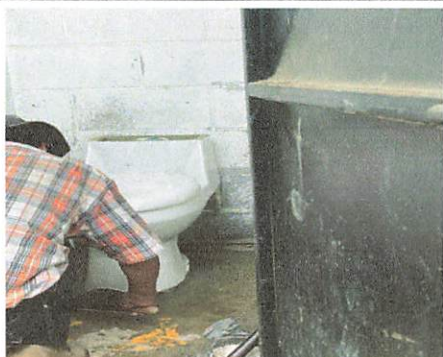
Foto 3: Instalacion de sanitario
