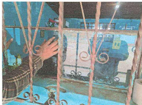
Foto 2: sustitucion de vidrios
