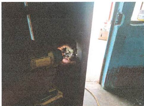
Foto1: Instalacion de chapas
