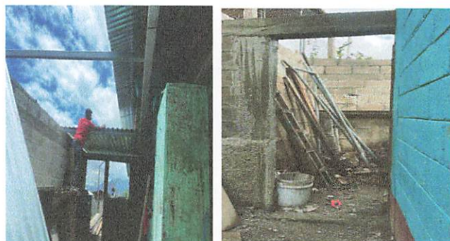
Foto 4: Instalacion de lamina troquelada y soporte de metal
