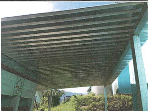
Foto 7: Techado de lamina Troquelada y soporte de metal
