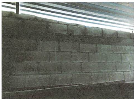
Foto 5: Construcccion de pared de block
