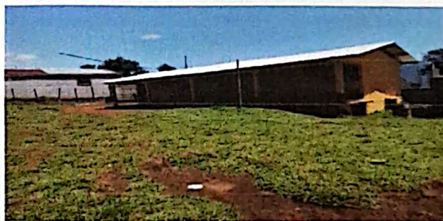
Foto 6: Sustrucción de laminas
