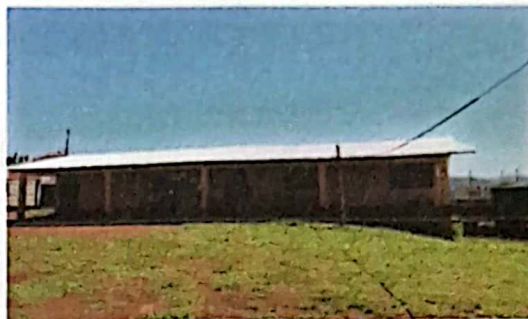
Foto 2: Sustrucción de capotes de lamina
