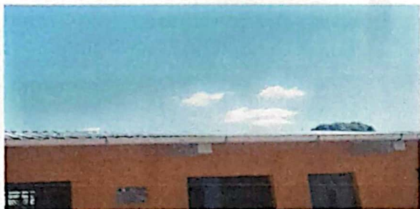
Foto 1: Sustrucción de capote de lamina
