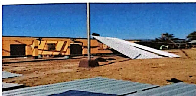
Foto 4: Sustrucción de lamina por lamina
