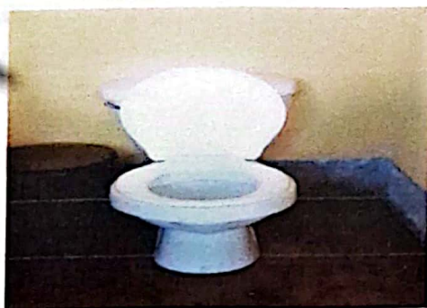
Foto 5: Sustrucción de accesorios de Inodoro
