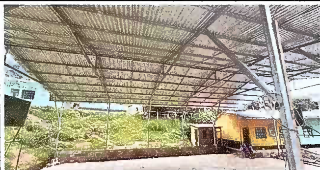
FOTO 1: sustitucion de lamina troquelada
