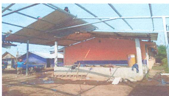
Foto 3: Sustitucion de lamina por lamina troquelada
