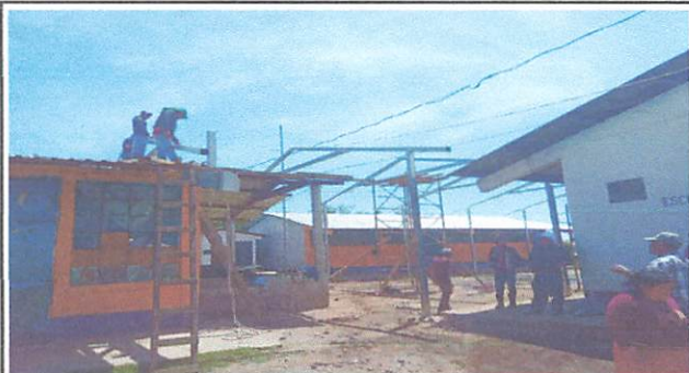
Foto1: Sustitucion de lamina por lamina troquelada
