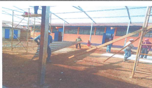
Foto 2: Sustitucion de soporte de madera por metal
