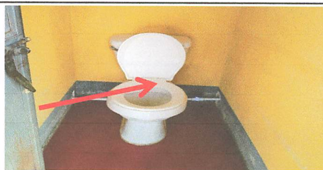
Foto 2: Modulo 3 Asi quedaron los sanitarios con un ambiente agradable despues de haber ejecutado dicho proyecto.
