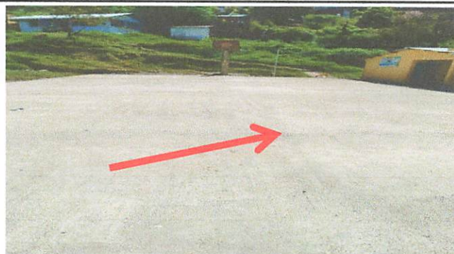
Foto 2: Modulo 2 Asi quedo la cancha despues de haberce ejecutado dicho proyecto.
