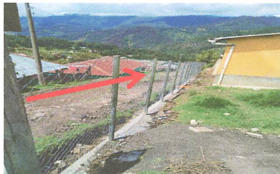
Foto 2 : Modulo 1 Asi quedo terminada la obra de la circulacion de l edificio escolar despues de haber cambado los tubos y la malla
