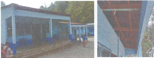
Foto1: Sustitucion de láminas y sustitucion deestructuras de soporte de madera por metal
