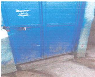
Foto 5: Mantenimiento de puertas de metal
