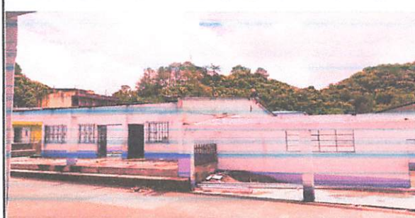
Foto1: sustitucion de laminas y sustitucion de estructuras de soporte de madera por metal
