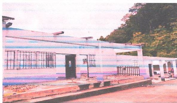
Foto 2: sustitucion de laminas y vigas
