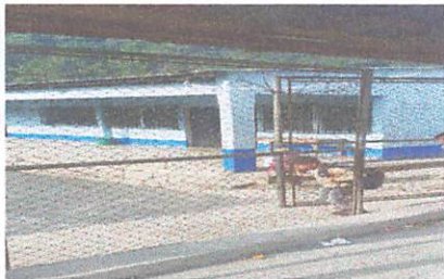
Foto 3: Mantenimiento de porton
