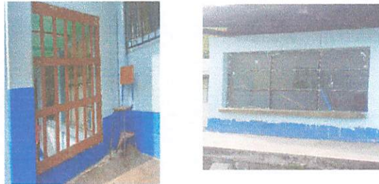
Foto 2: Sustitucion de barrandas y sustitucion del balcon
