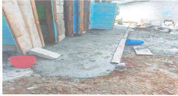
Foto 4: REPARACION DE PISO TORTA Y SUSTITUCION DE SANITARIOS
