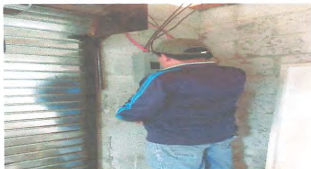
Foto7: SUSTITUCION DE TABLERO Y FLIPONES
