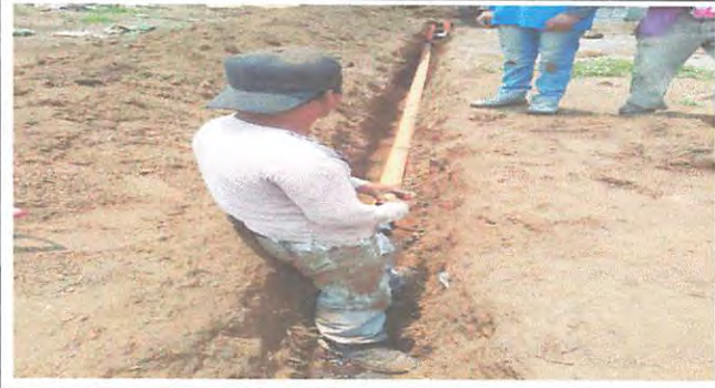
FOTO 16: PROCESO DE INSTALACION DE TUBERIA DE DRENAJE
