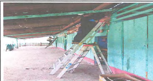
Foto 5: REPARACION DE CABLEADO ELECTRICO
