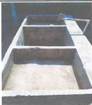
Foto 9: SUSTITUCION DE LLAVE DE CHORROS
