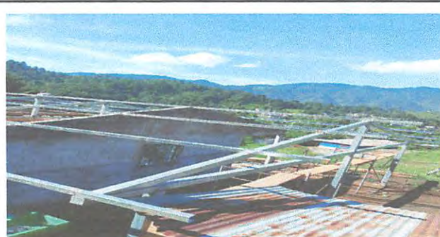
Foto 10: SUSTITUCION DE LAMINA, POR LAMINA TROQUELADA ALUZINC CALIBRE 26
