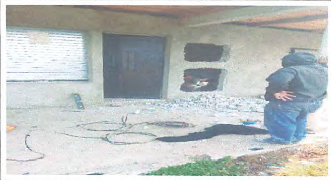
Foto 14: PROCESO DE COLOCACION DE NUEVA PUERTA
