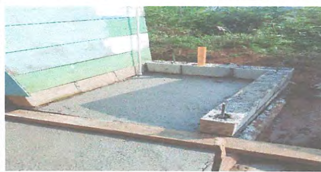
Foto 2: PREPARACION PARA LA INSTALACION DEL MIGITORIO
