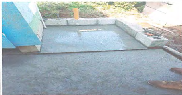
Foto 1: PREPARACION PARA LA INSTALACION DE LOS NUEVOS SANITARIOS
