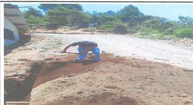
Foto 6: PROCESO DE INSTALACION DE AGUA POTABLE
