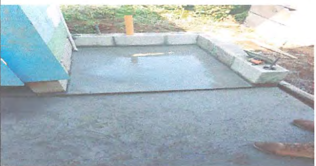
Foto 3: REPARACION DE PISO TORTA
