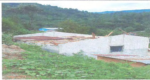
Foto 12: SUSTITUCION DE SOPORTE DE MADERA POR METAL
