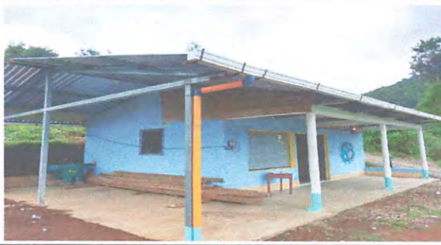
Foto13: SUSTITUCION DE CANAL DE PVC
