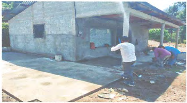
FOTO 15: REPARACION DE PISO TORTA DE CONCRETO EN EL CORREDOR DE LA COCINA
