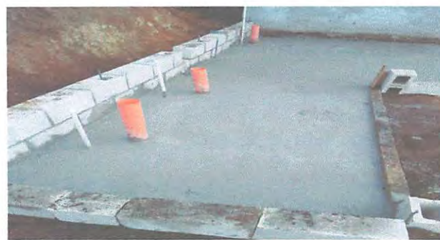
Foto 8: AQUÍ SE INSTALARA LA PILA DE PLASTICO DE DOS LAVADEROS
