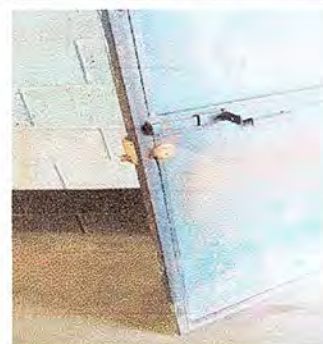
Foto 6: Módulo 2, Sustitución de chapa
