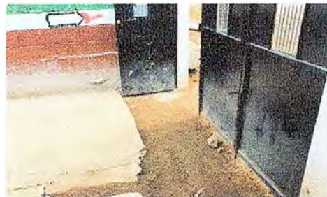
Foto 10: Área exterior, reparación de rampa
