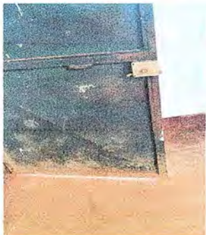
Foto 7: Módulo 2, Sustitución de chapa
