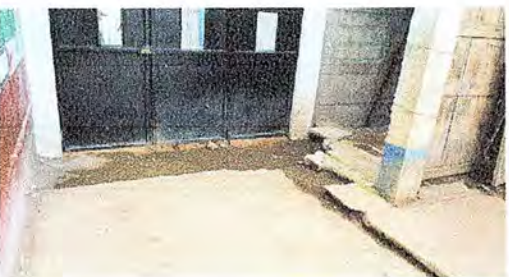
Foto 11: Área exterior, reparación de rampa
