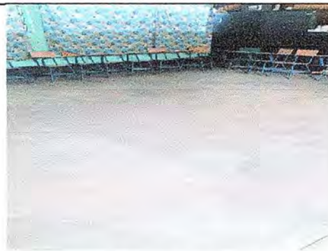
Foto 4: Módulo 2, Sustitución de piso de torta por piso de granito
