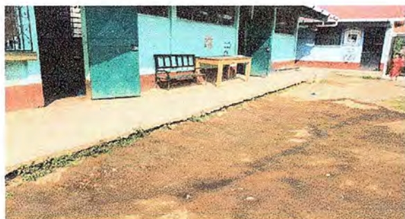
Foto 5: Módulo 2, Reparación de bordillo
