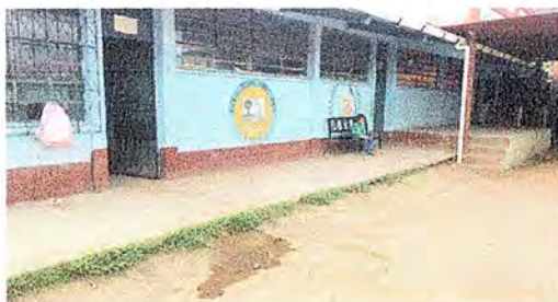
Foto 9: Módulo 3, Reparación de bordillo
