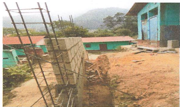
Foto 4: Reparacion de pila. Y sus Asesorios.
