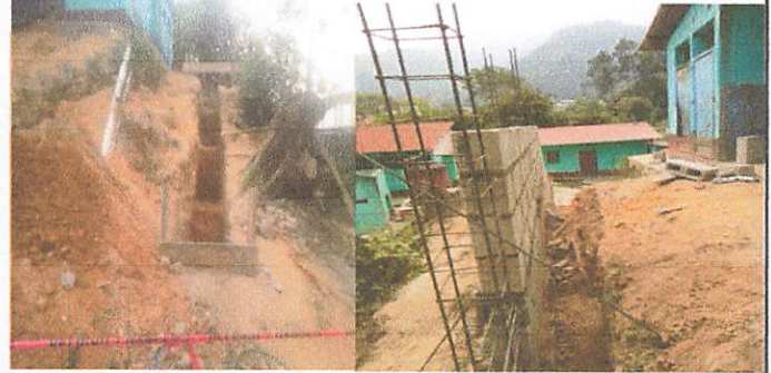
Foto 2: Sustitucion, Ampliacion y cernido en gradass. Reparacion muro de contencion.
