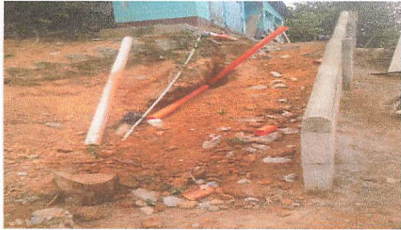
Sustitución de tubería PVC línea principal agua potables y sustitucion de drenaje aguas negras.
