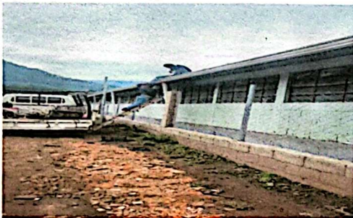
Foto 3: Sustitución de soporte o pescante de metal para canal
