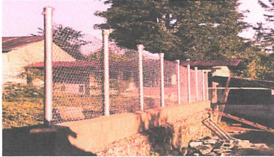
Foto 1: MURO PERIMETRAL Reparación tubo HG y malla galvanizada
