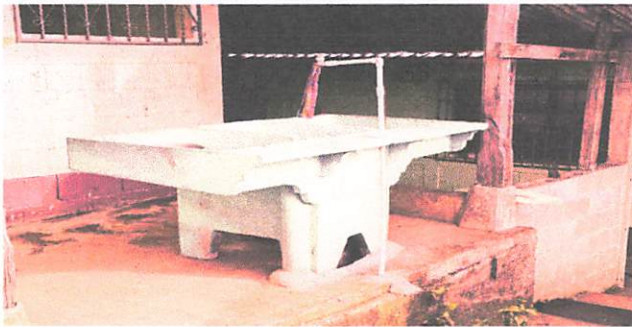
Foto 3: AREA EXTERIOR Sustitución de pila
