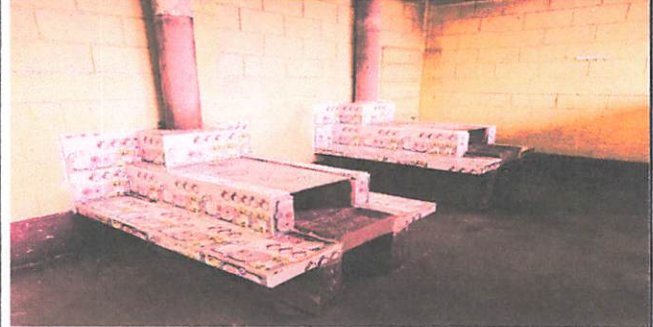
Foto 4: AREA EXTERIOR Reparación de plancha de concreto
