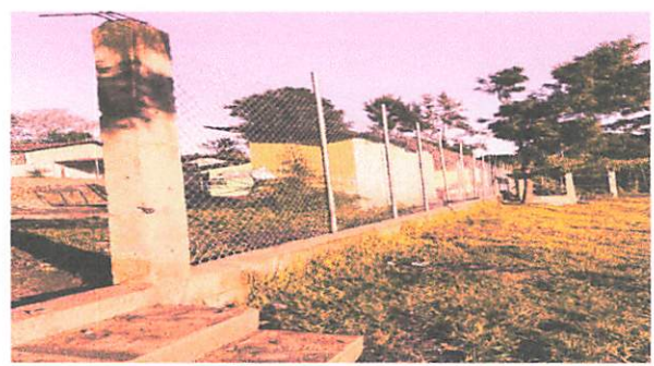
Foto 2: MURO PERIMETRAL Reparación de muro perimetral de block, tubo HG, malla galvanizada
