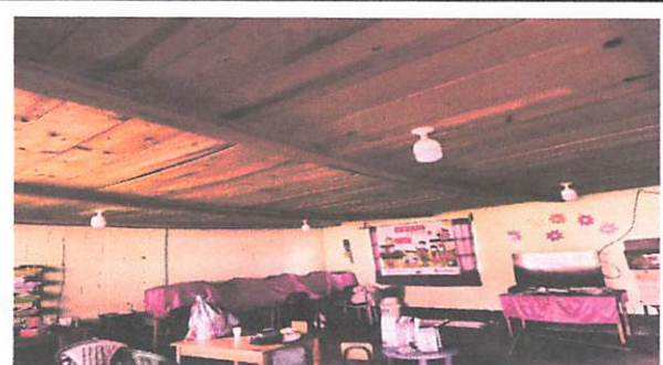
Foto 6: MODULO 1 Reparación de cableado eléctrico
