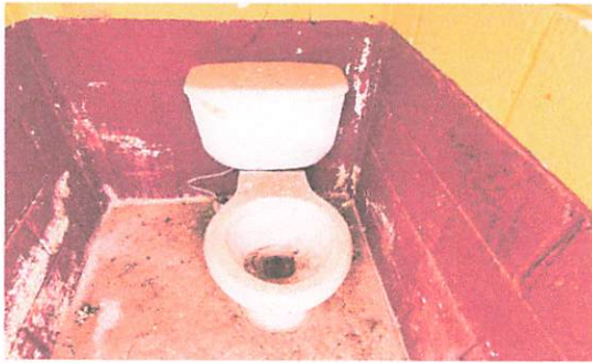
Foto 5: MODULO 6 Sustitución de inodoro, Instalación de inodoro.
