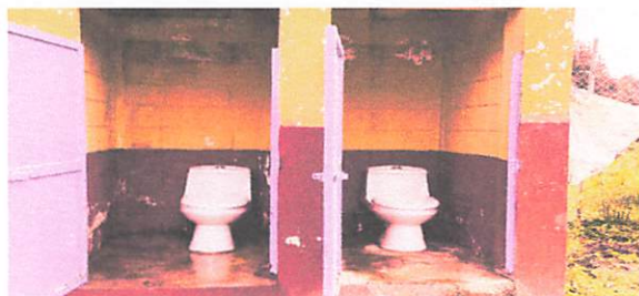
Foto 5: MODULO 6 Sustitución de inodoro, Instalación de inodoro.
