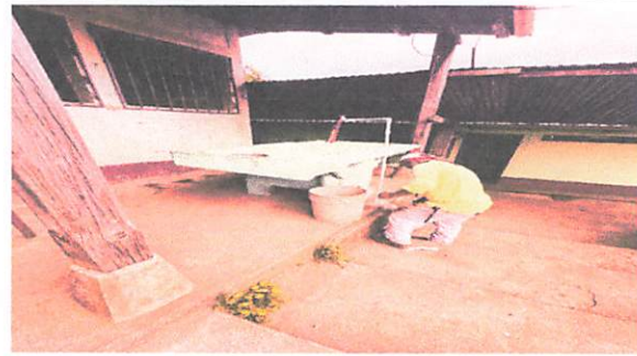
Foto 3: AREA EXTERIOR Sustitución de pila
