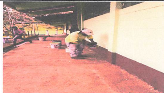
Foto 6: PINTURA GENERAL Pintura de muros interiores y exteriores
