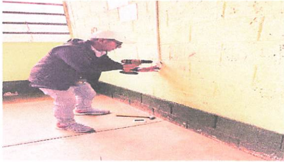
Foto1: MODULO 2 Reparación de cable electrico
