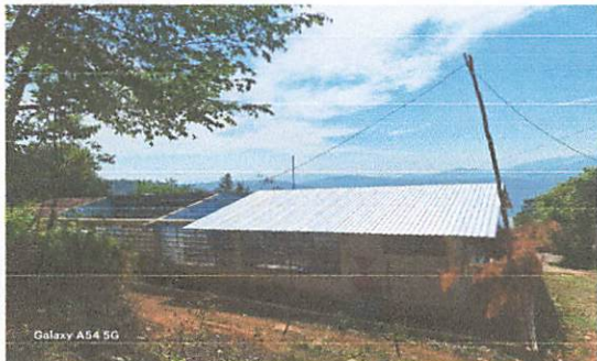
Foto1: Sustrución de lamina por lamina troquelada
