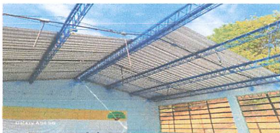
Foto 3: Sustrución de estructura de soporte rectangular
