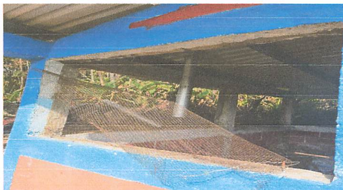
Foto 4: Sustrución de balcones
