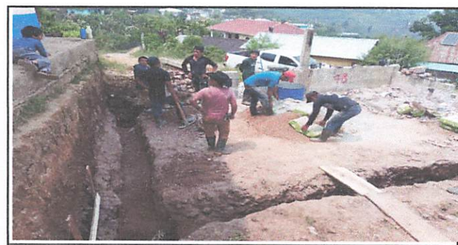
Foto 6: cimiento de cocina
