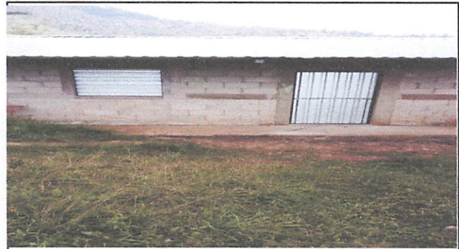
Foto 2: sustitucion de puerta
