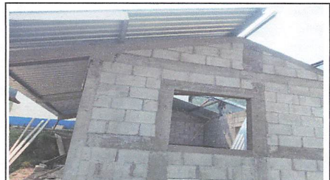
Foto 4: sustitucion de lamina
