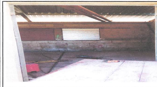
Foto 3: sustitucion de piso de concreto
