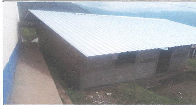
Foto1: sustitucion de portante de madera a metal
