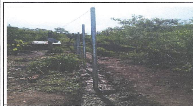
Foto 5: sutitucion de muro perimetral
