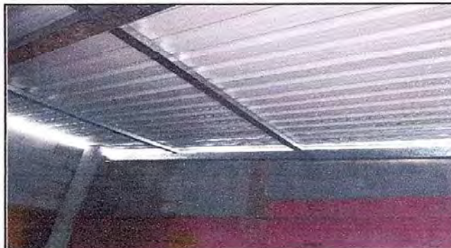
Foto 2: Módulo 1. Sustitucion de estructura de soporte de madera por metal. EODP. Anexa a EORM. Aldea Chuaquenum, Joyabaj, Quiché.
