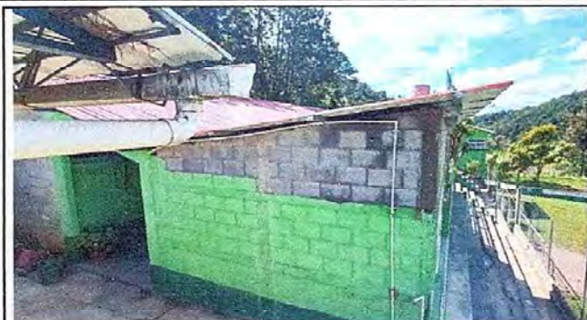
Foto1: Módulo 1 Sustitucion de lámina por lámina troquelada Aluzink. EODP. Anexa a EORM. Aldea Chuaquenum, Joyabaj, Quiché.
