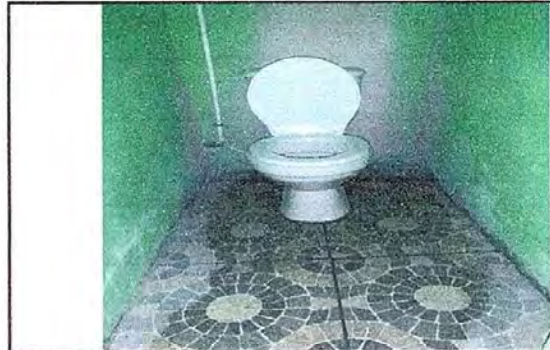
Foto 8: Módulo 1. Sustitución de inodoros. EODP. Anexa a EORM. Aldea Chuaquenum, Joyabaj, Quiché.
