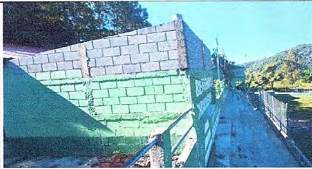
Foto 1: Módulo 1 Sustitución de lámina por lámina troquelada Aluzink. EODP. Anexa a EORM. Aldea Chuaquenum, Joyabaj, Quiché.
