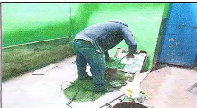
Foto 9: Módulo 1 Sustitución de Migitorios. EODP. Anexa a EORM. Aldea Chuaquenum, Joyabaj, Quiché.
