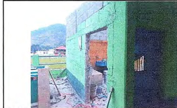
Foto 4: Módulo 1 Sellado de vano. EODP. Anexa a EORM. Aldea Chuaquenum, Joyabaj, Quiché.
