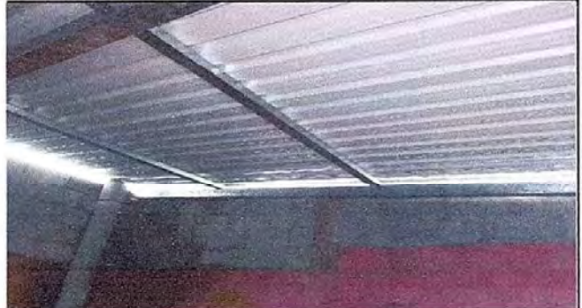
Foto 2: Módulo 1. Sustitución de estructura de soporte de madera por metal. EODP. Anexa a EORM. Aldea Chuaquenum, Joyabaj, Quiché.
