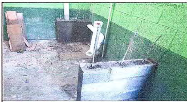
Foto 12. modulo 1 Sustitucion de Lavamanos. (INSITU). EODP. Anexa a EORM. Aldea Chuaquenum, Joyabaj, Quiché.
