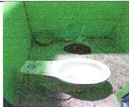
Foto 8: Módulo 1. Sustitución de inodoros. EODP. Anexa a EORM. Aldea Chuaquenum, Joyabaj, Quiché.
