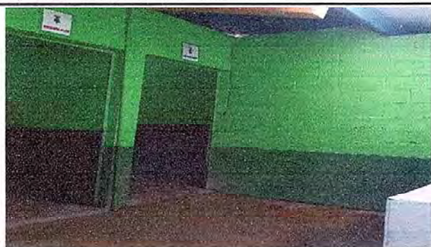
Foto 7: Módulo 1 Mantenimiento de puertas de metal en baños. EODP. Anexa a EORM. Aldea Chuaquenum, Joyabaj, Quiché.
