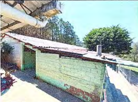
Foto1: Módulo 1 Sustitucion de lámina por lámina troquelada Aluzink. EODP. Anexa a EORM. Aldea Chuaquenum, Joyabaj, Quiché.
