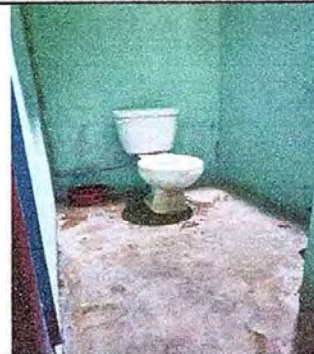
Foto 8: Módulo 1. Sustitución de inodoros. EODP. Anexa a EORM. Aldea Chuaquenum, Joyabaj, Quiché.
