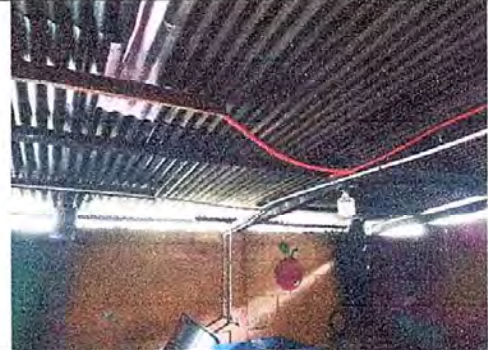
Foto 2: Módulo 2. Sustitucion de estructura de soporte de madera por metal. EODP. Anexa a EORM. Aldea Chuaquenum, Joyabaj, Quiché.
