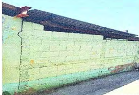
Foto 10: Módulo 1 Levantado de mojinete en cocina. EODP. Anexa a EORM. Aldea Chuaquenum, Joyabaj, Quiché.
