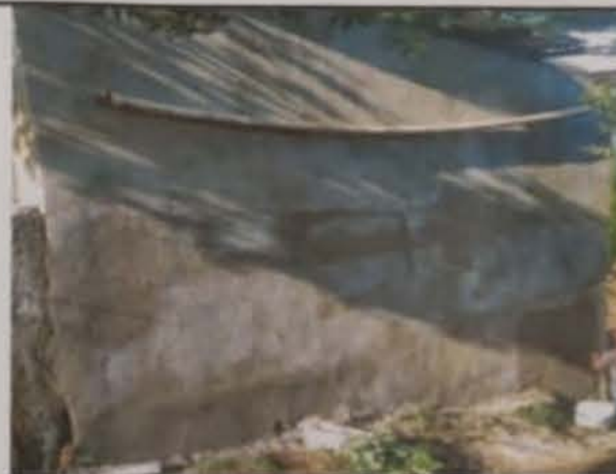
Modulo 5: Aplicación de repello en muro de contención.
