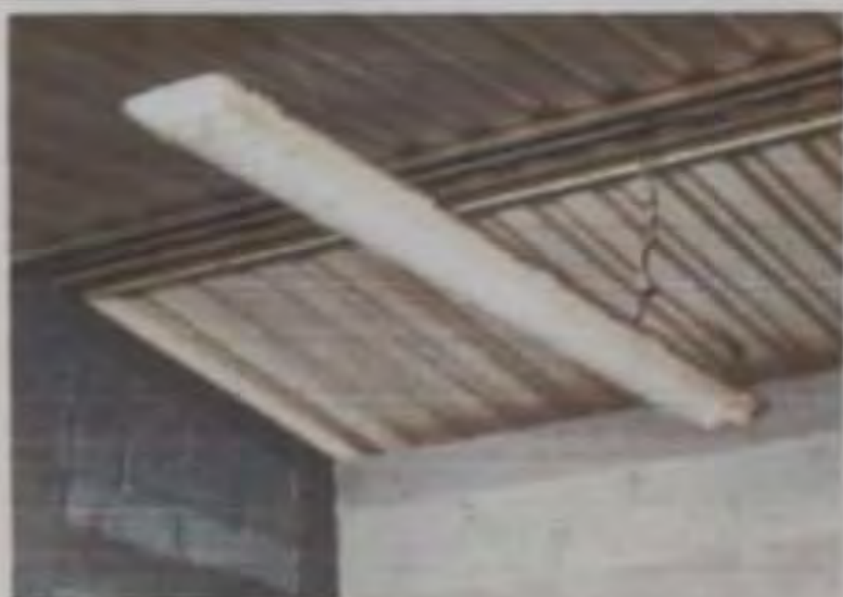
Módulo 2: Reparación del cableado eléctrico, sustitución de ducto eléctrico más accesorios.
