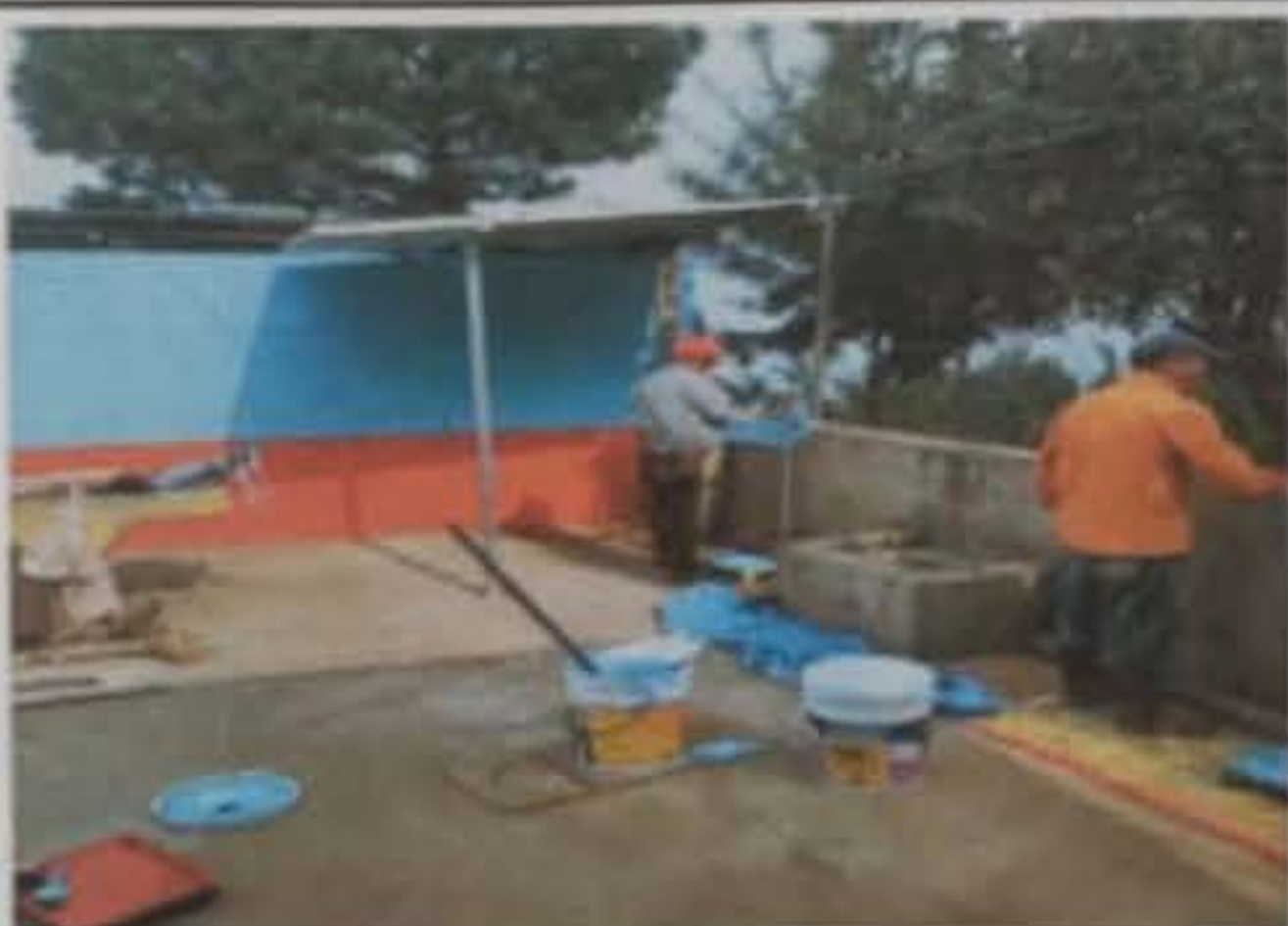
Modulo 4: Pintura en muros exteriores e interiores.
