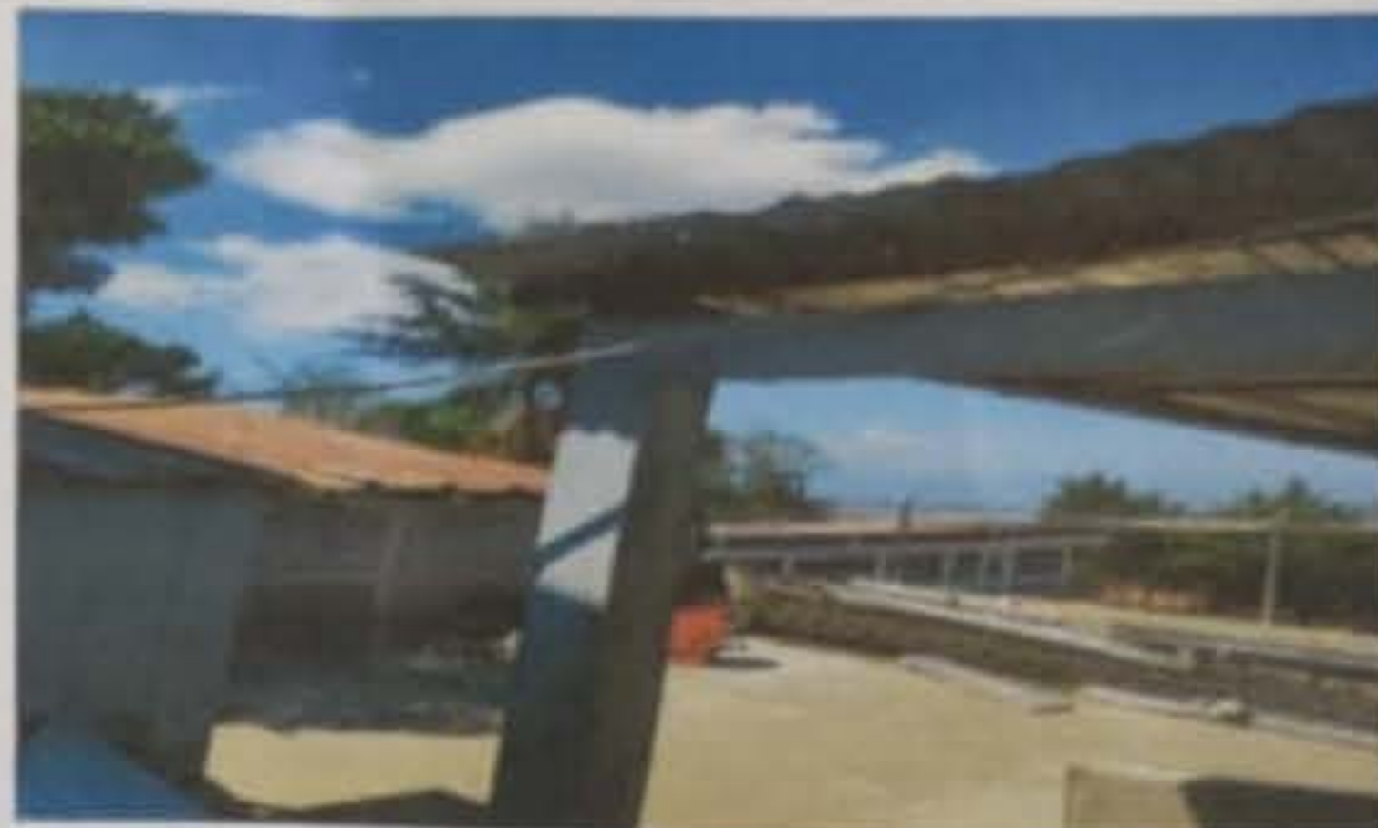
Modulo: Sustrucción de tubería lineal principal de abastecimiento de agua potable.
