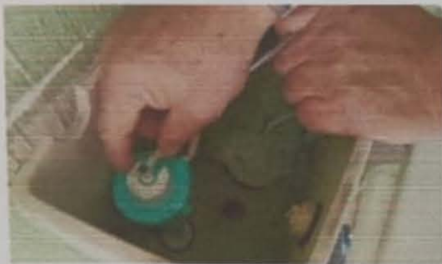
Modulo 3: Sustitución de accesorios de inodoro
