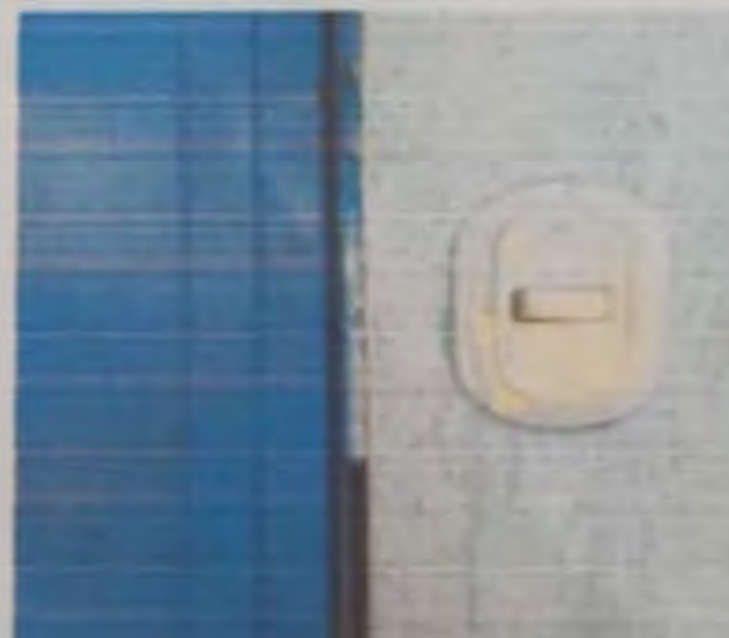
Modulo 2: Sustitución de interruptores dobles
