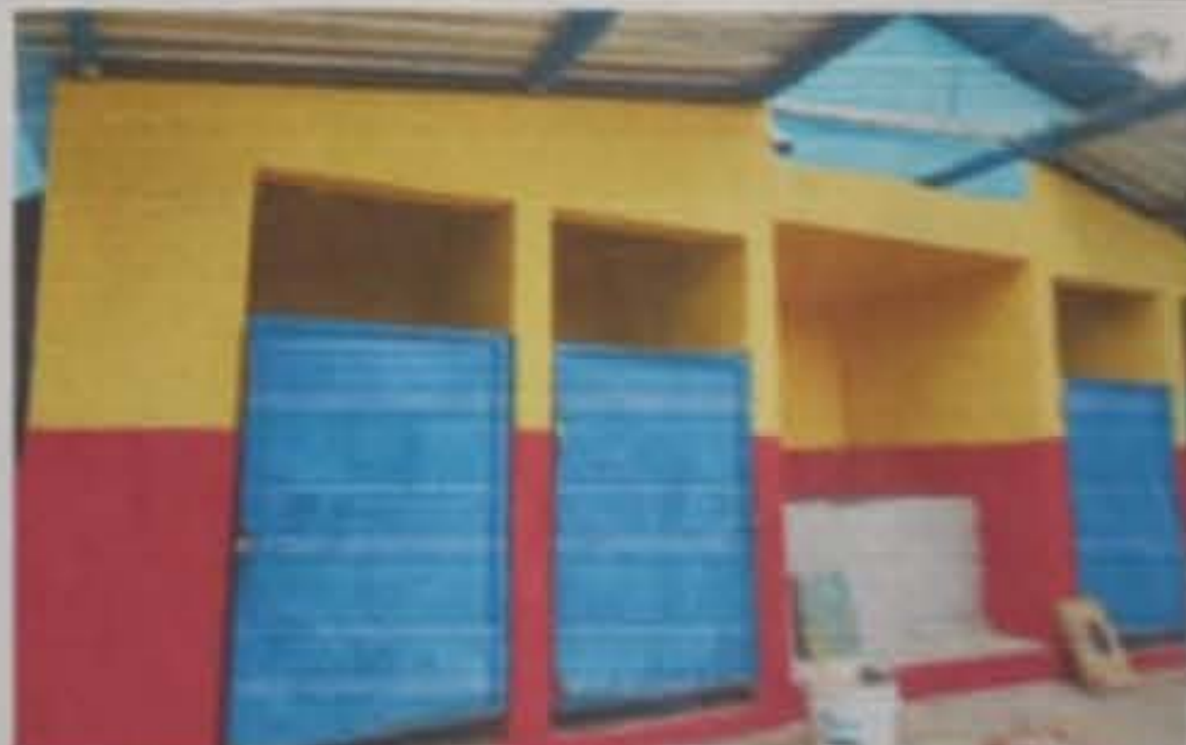
Modulo 3: Pintura en muros interiores y exteriores.
