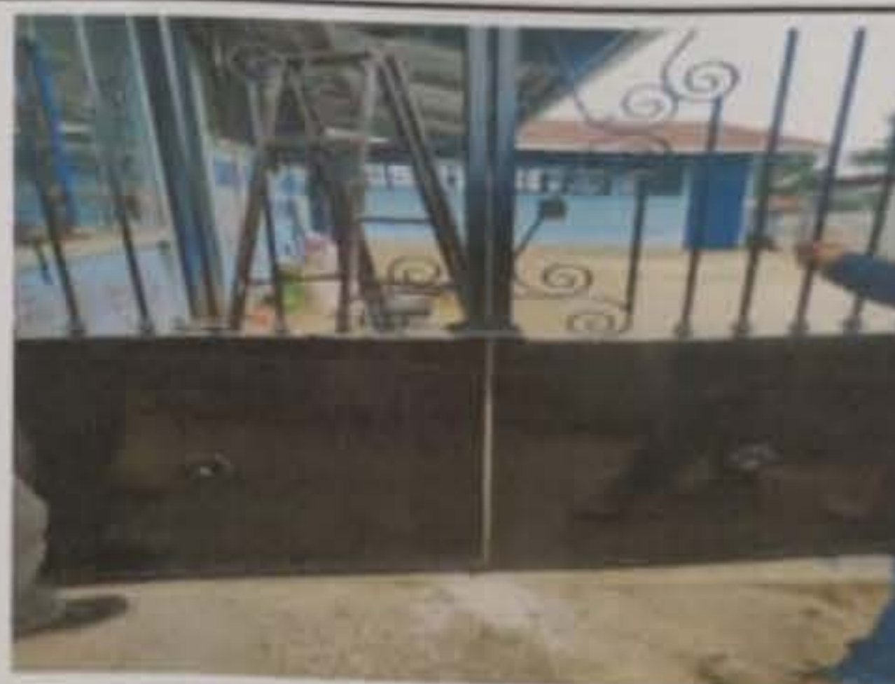
Modulo 5: Sustrucción portón de metal.
