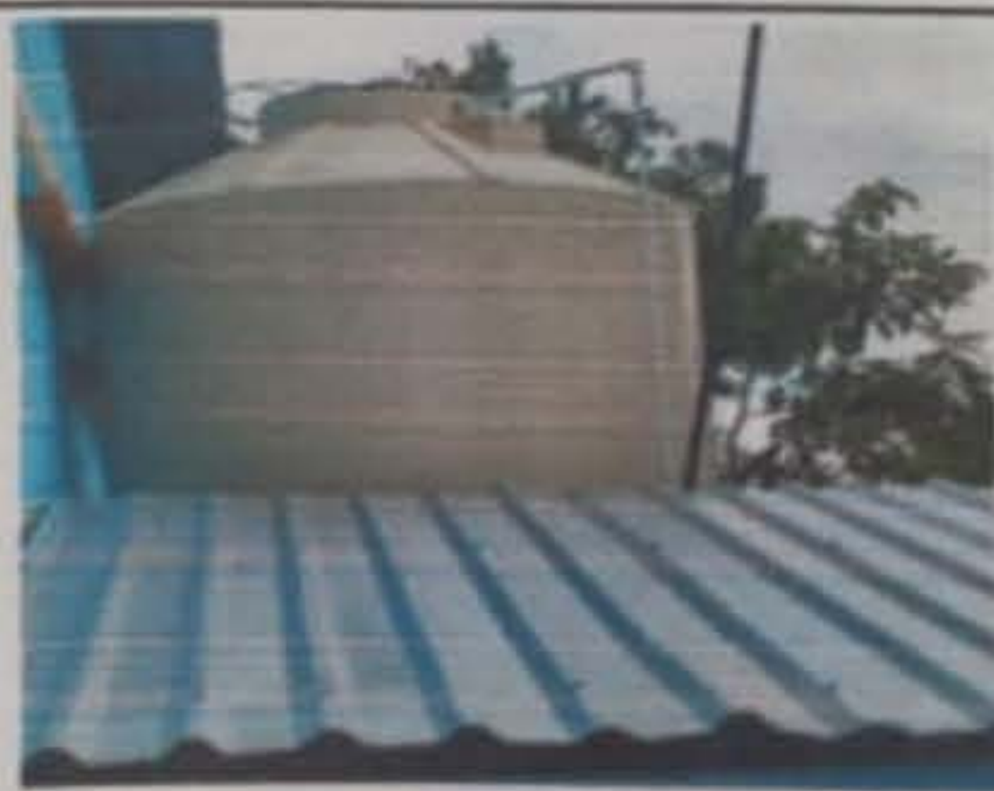
Modulo 3: Sustitución de deposito de agua 1700 lt.
