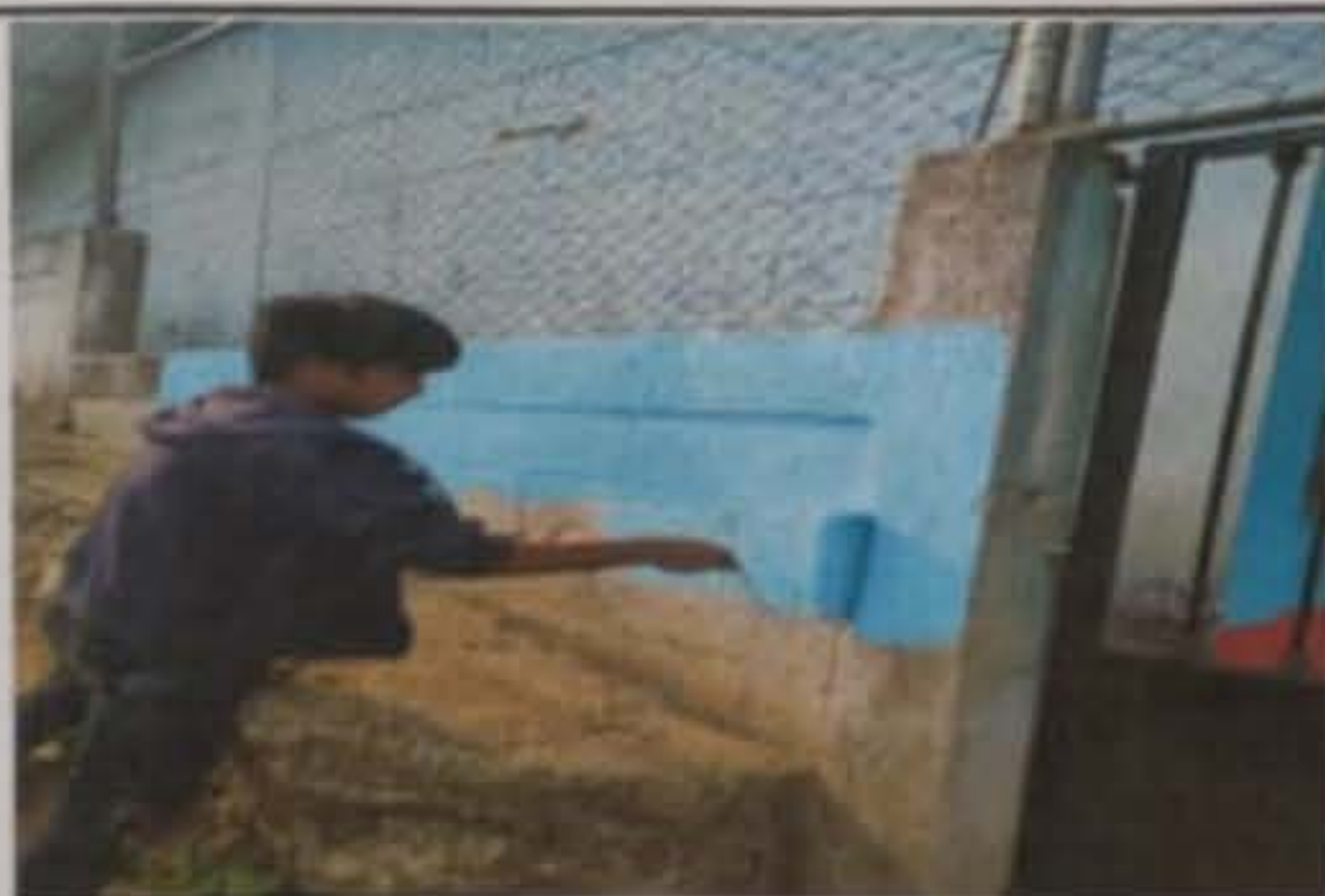
Modulo 5: Pintura en muros exteriores e interiores.
