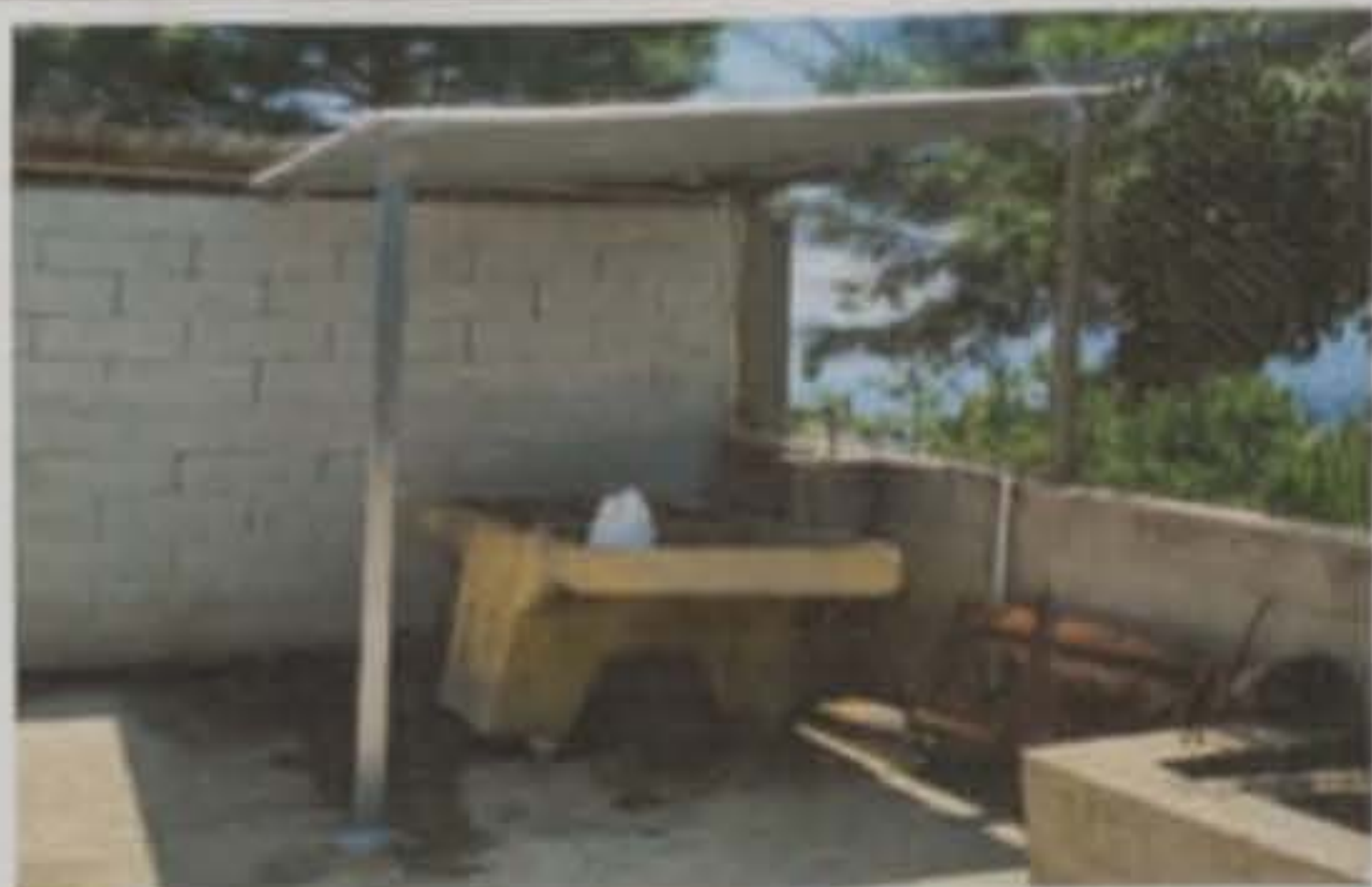
Modulo 4: Sustrucción de pila de cemento de dos lavaderos, sustrucción de llave de globo, llave de chorro e instalación de estructura portante de metal.
