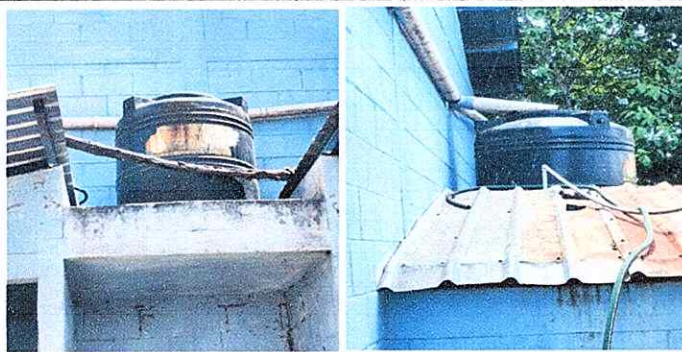
Modulo 3: Sustitución de deposito de agua 1700 lt.
