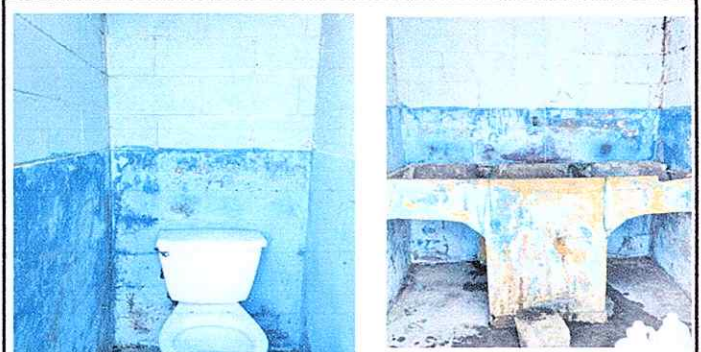
Modulo 3: Pintura en muros interiores y exteriores.
