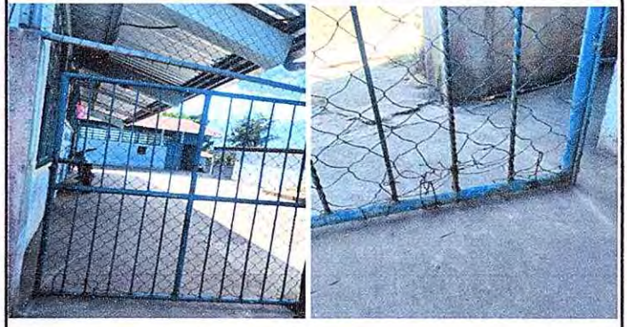
Modulo 5: Sustitución portón de metal.
