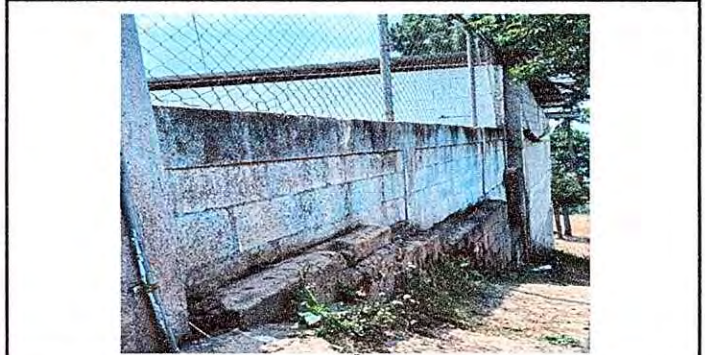
Modulo 5: Aplicación de repello en muro decontención.
