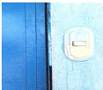
Modulo 2: Sustitución de interruptores dobles
