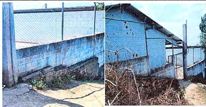
Modulo 5: Pintura en muros exteriores e interiores.
