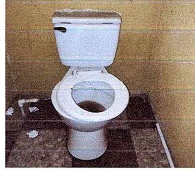
Foto 4: MÓDULO II: Cambio de tazas sanitarias
