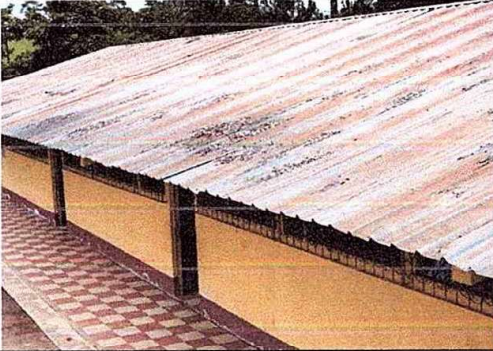
Foto 1: MÓDULO I: Sustitución de lámina por lámina troquelada Aluzinc calibre 26.
