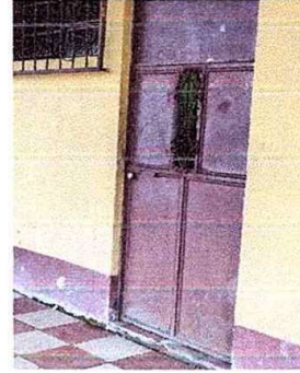
Foto 2: MÓDULO I: Sustitución de puerta de metal y pintura en muros exteriores e interiores
