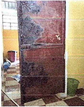
Foto 3: MÓDULO II: Sustitución de puertas de metal por PVC en Servicios Sanitarios
