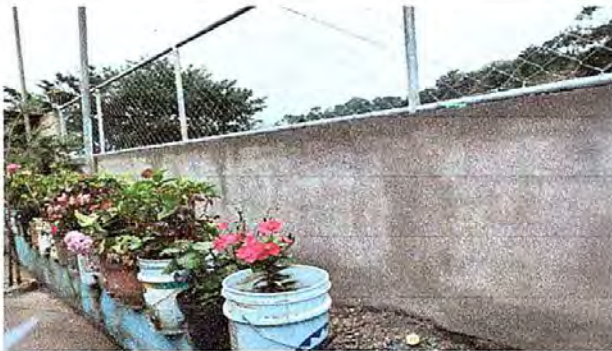
FOTO 9: MURO PRIMETRAL: Reparación de muro perimetral de block con tubo hg, malla galvanizada soleras intermedias y columnas.
