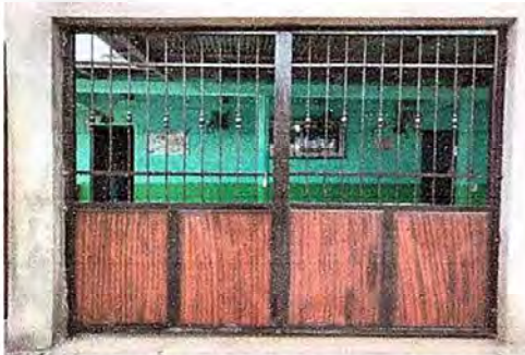
FOTO 11: MURO PERIMETRAL: Sustitución de portón de metal.
