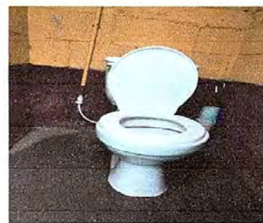
FOTO 6: MODULO 2: sustitución de inodoros.
