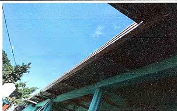
FOTO 2: MODULO 1: Sustrucción de canal PVC.
