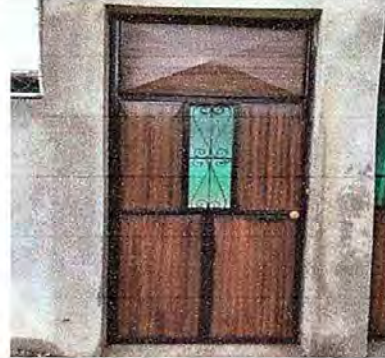
FOTO 10: MURO PERIMETRAL: sustitución de puerta de metal.
