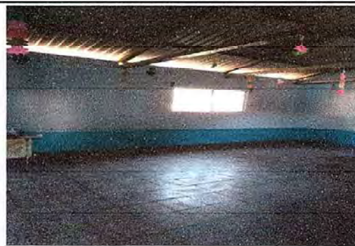
FOTO 4: MODULO 1: Pintura de muros interiores y exteriores.
