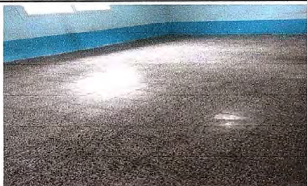
FOTO 1: MODULO 1: Sustrucción de piso de torta de concreto por piso de granito.
