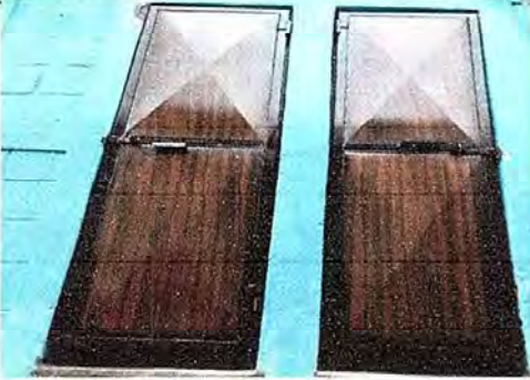
FOTO 7: MODULO 2: Sustitución de puerta en servicios sanitarios.
