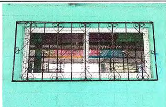
FOTO 3: MODULO 1: Sustrucción de estructura de metal de ventanas.
