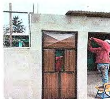
FOTO 10: MURO PERIMETRAL: sustitución de puerta de metal.
