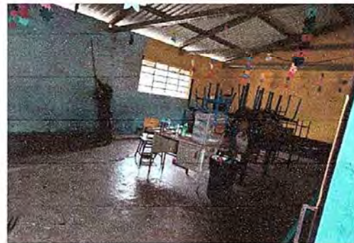
FOTO 4: MODULO 1: Pintura de muros interiores y exteriores.
