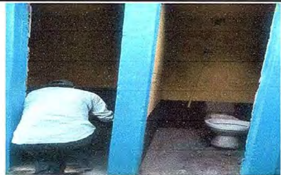
FOTO 6: MODULO 2: sustitución de inodoros.
