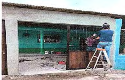
FOTO 11: MURO PERIMETRAL: Sustrucción de porton de metal.
