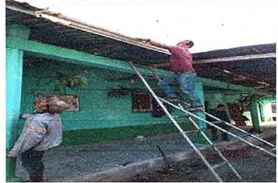
FOTO 2 :MODULO 1: Sustitución de canal PVC.
