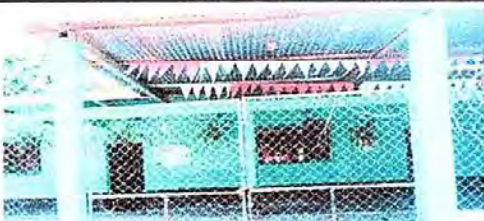
FOTO 9: MURO PRIMETRAL: Reparación de muro perimetral de block con tubo hg, malla galvanizada soleras intermedias y columnas.
