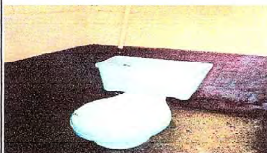
FOTO 6: MODULO 2: sustitución de inodoros.
