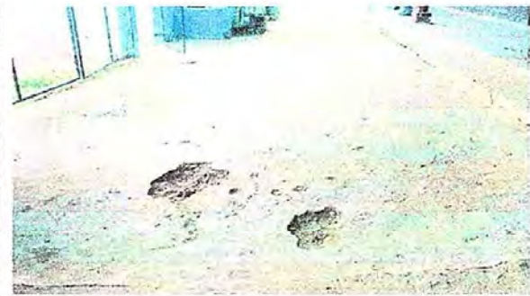
FOTO 8: PATIO: Reparacion de plancha de concreto de patio.
