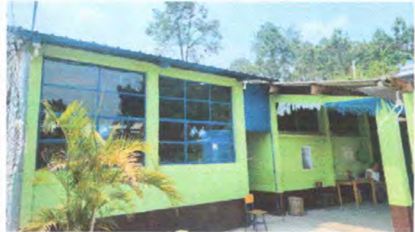
Foto 2: MÓDULO 1: Sustitución de lámina, por lámina troquelada y estructura de metal
