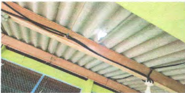
Foto 3: MÓDULO 1: Sustitución de lámina duralita por lámina troquelada y mantenimiento de estructura portante de metal
