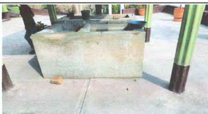
Foto 11: MÓDULO 4: Sustrucción de pila
