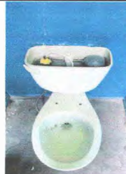
Foto 8: MÓDULO 3: Sustrucción de onodoros
