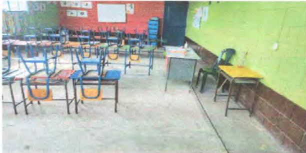
Foto1: MÓDULO 1: Sustitución de piso de torta de concreto por piso cerámico
