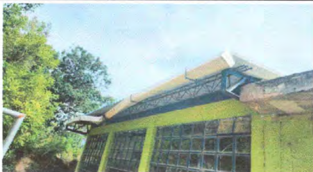
Foto 7: MÓDULO 2: Sustrucción de canal de metal
