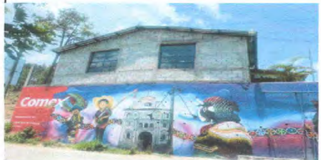
Foto 4: IMÓDULO 1: Pintura en muros exteriores e interiores
