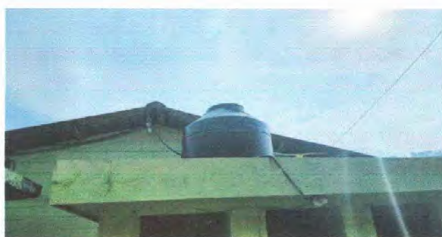
Foto 10: MÓDULO 3: Sustrucción de depósito de agua 2,500 L.
