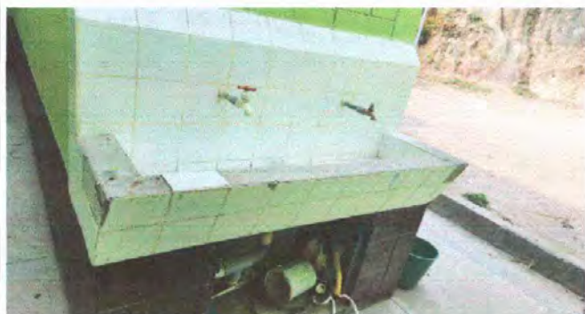
Foto 9: MÓDULO 3: Sustrucción de azulejos
