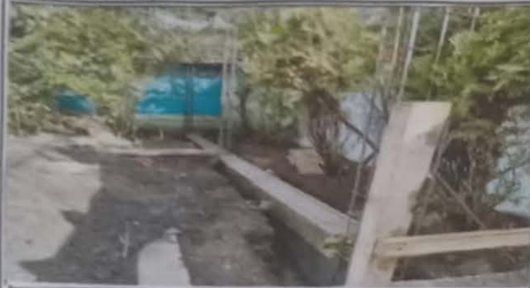
Foto 1: Pared de muro perimetral en proceso.
