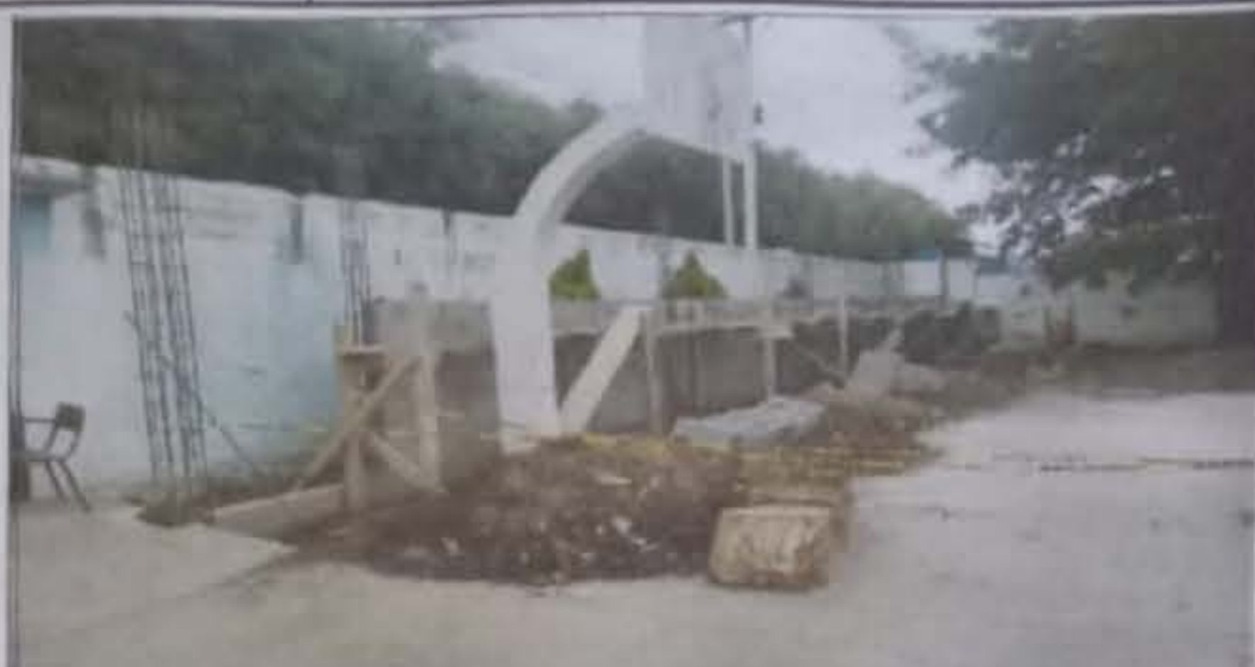
Foto 2: Pared de muro perimetral en proceso
