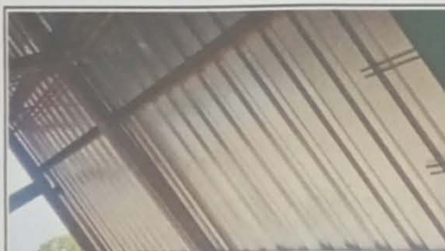
Foto 3: Sustrucción de lamina, por lamina troquelada aluzinc calibre 26
