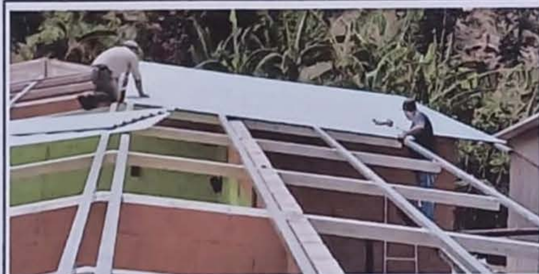
Módulo 2: Sustitución de lámina, por lámina troquelada aluzinc calibre 26
