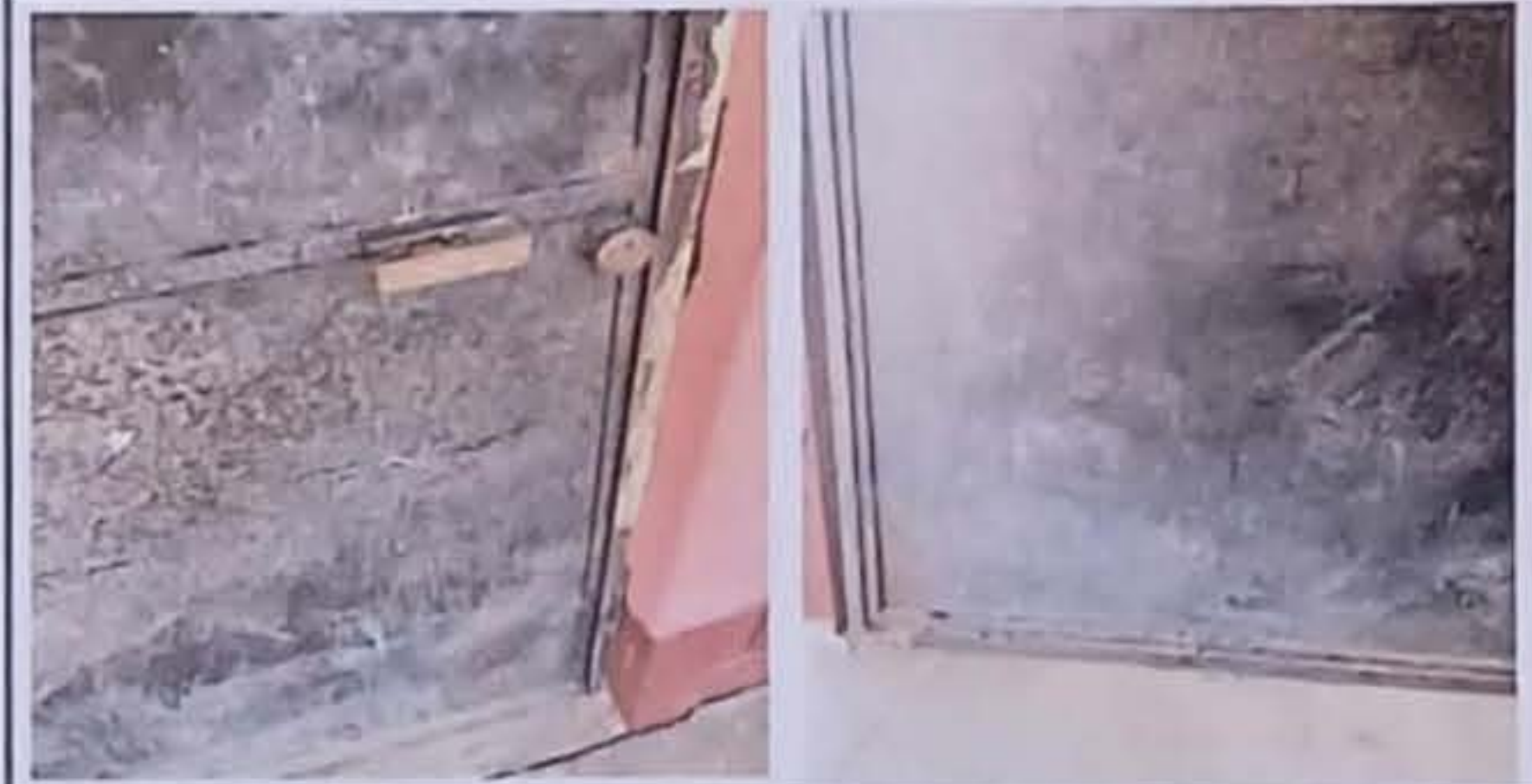
Módulo 2: Sustitución de puertas de metal
