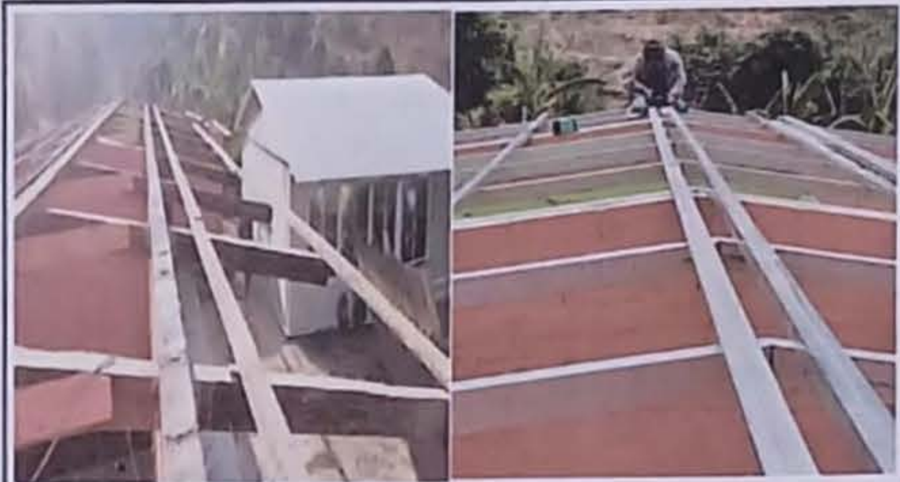
Módulo 2: Sustitución de estructura de soporte de madera por metal
