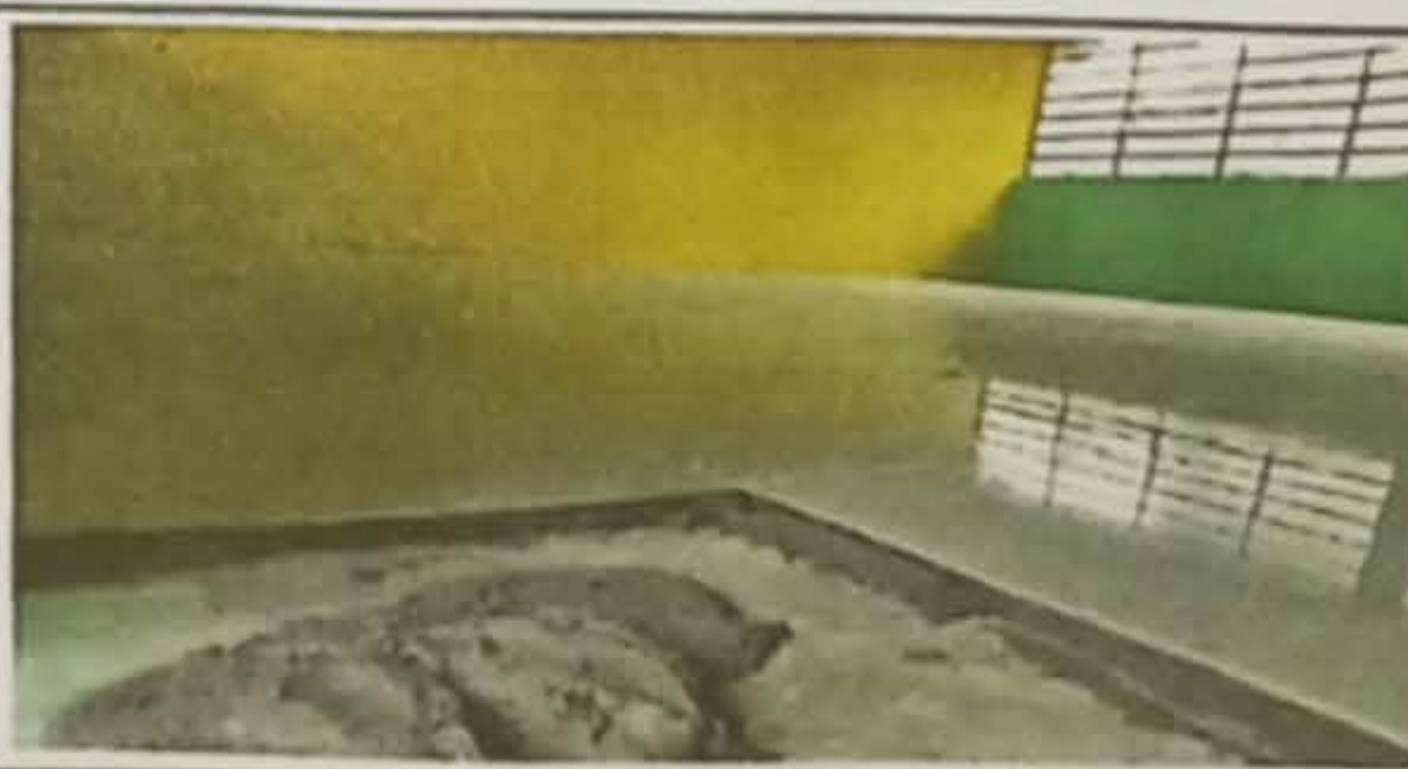
Modulo 2. Sustitución de piso de torta de concreto por piso cerámico y Pintura en muros exteriores e interiores.
