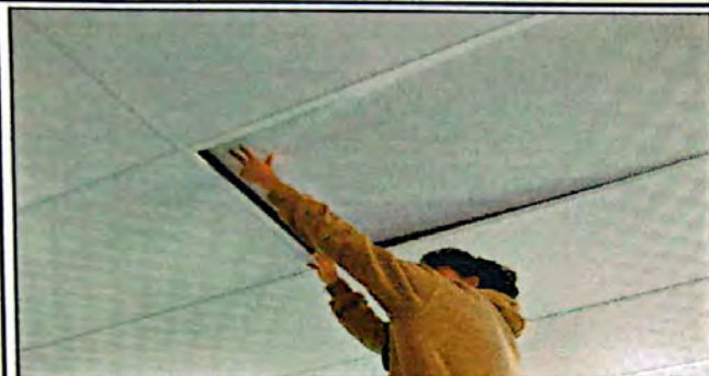
Módulo 4: Sustitución de cielo falso
