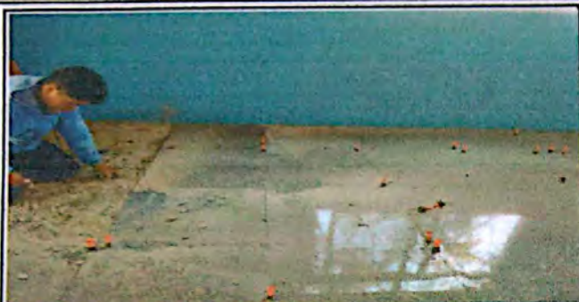
Módulo 1: Sustitución de piso porcelanato
