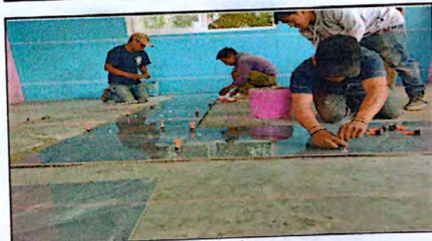
Módulo 4: Sustitución de piso porcelanato
