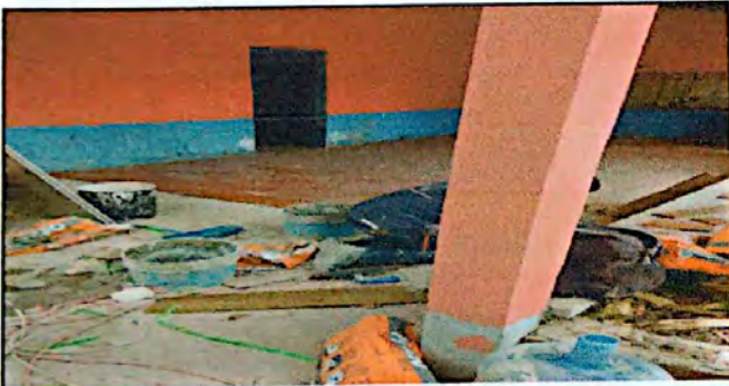
Módulo 1: Sustitución de piso cerámico
