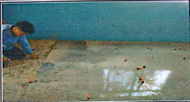
Módulo 1: Sustitución de piso porcelanato
