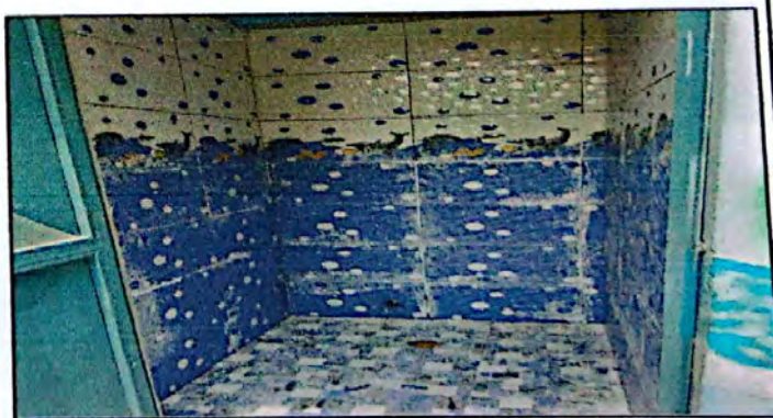
Módulo 2: Sustitución de azulejo
