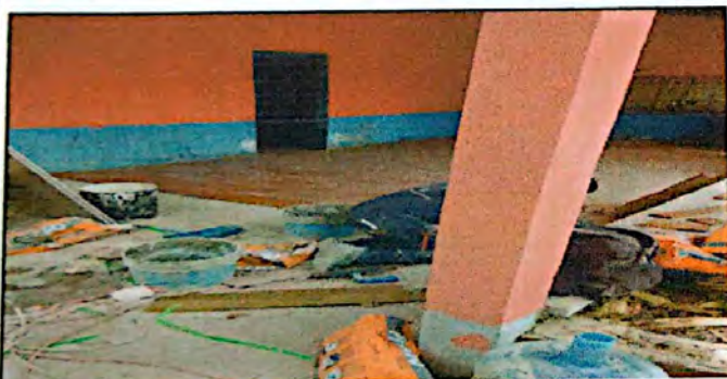
Módulo 1: Sustitución de piso cerámico
