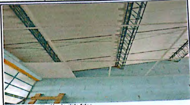
Módulo 1: Sustitución de cielo falso
