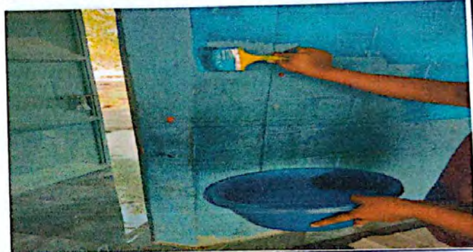
Módulo 1: Pintura de paredes interiores y exteriores
