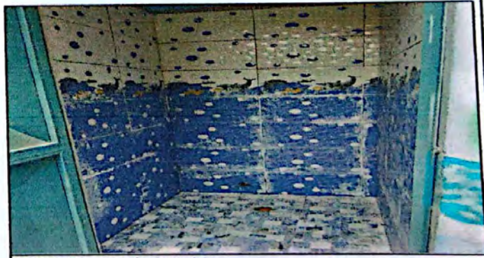
Módulo 2: Sustitución de azulejo
