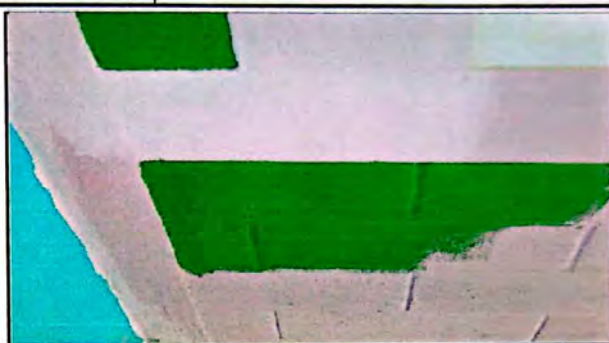
Módulo 4: Pintura de paredes interiores y exteriores
