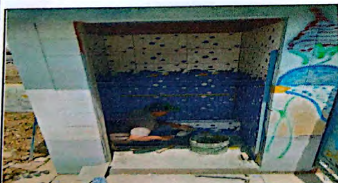
Módulo 2: Sustitución de piso cerámico
