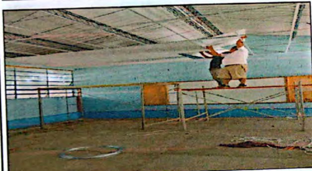
Módulo 3: Sustitución de cielo falso
