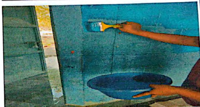
Módulo 1: Pintura de paredes interiores y exteriores
