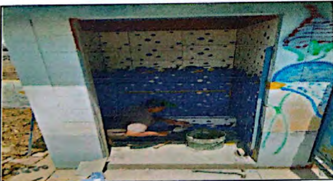
Módulo 2: Sustitución de piso cerámico
