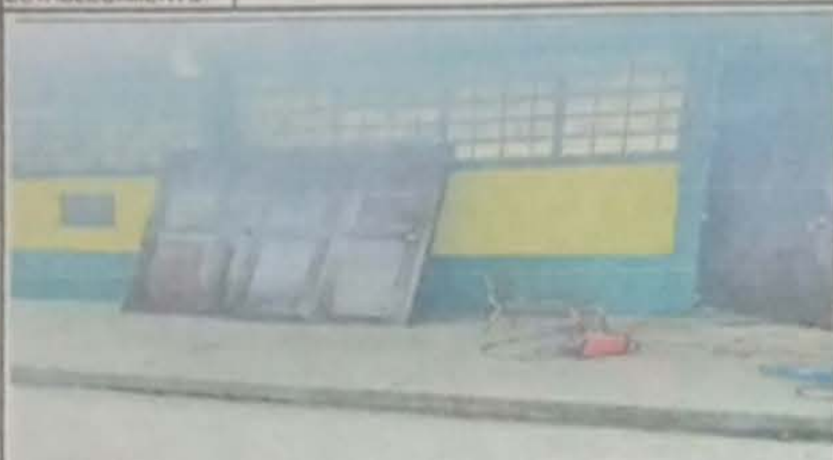
Foto 1: Sustitución de puerta (1x2.93mts)
