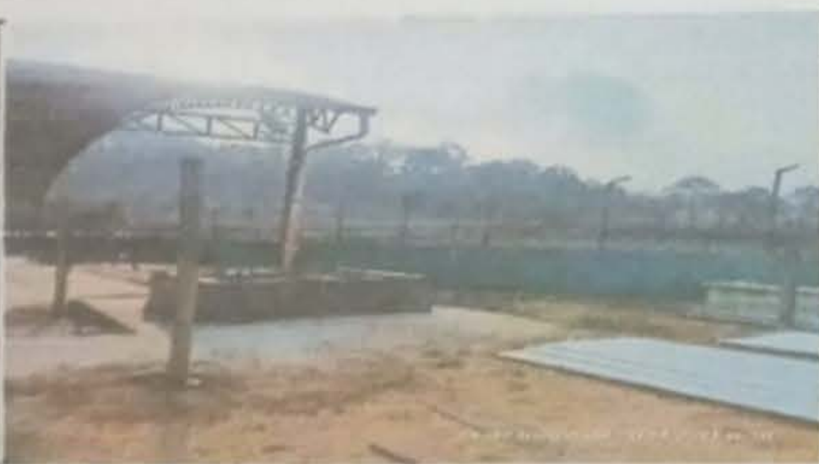
Foto 5: Sustitución de lámina, por lámina troquelada aluzinc calibre 26 y Sustitución de estructura de soporte de madera, por metal
