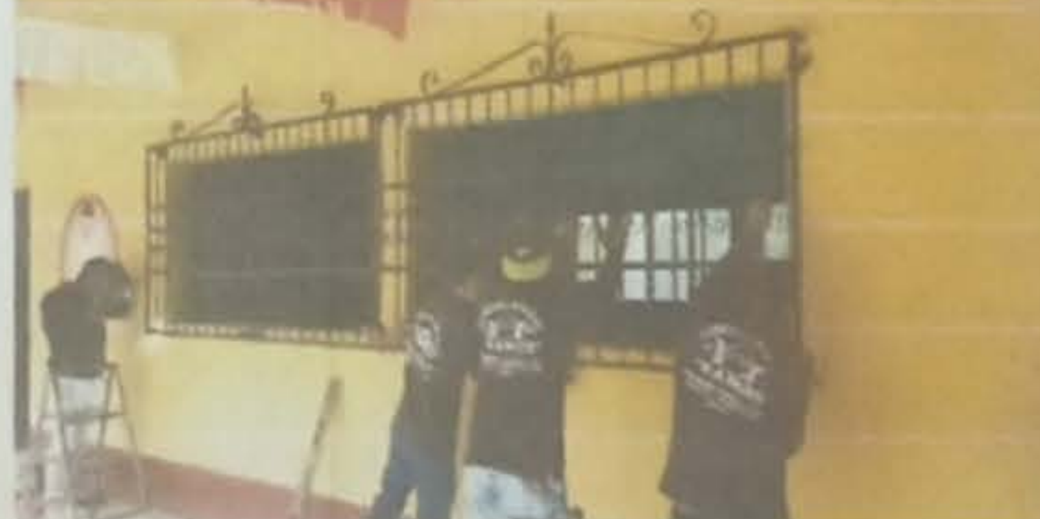
Modulo 3 Foto 6: Sustitución de estructura de metal, vidrio de ventana y balcones de metal
