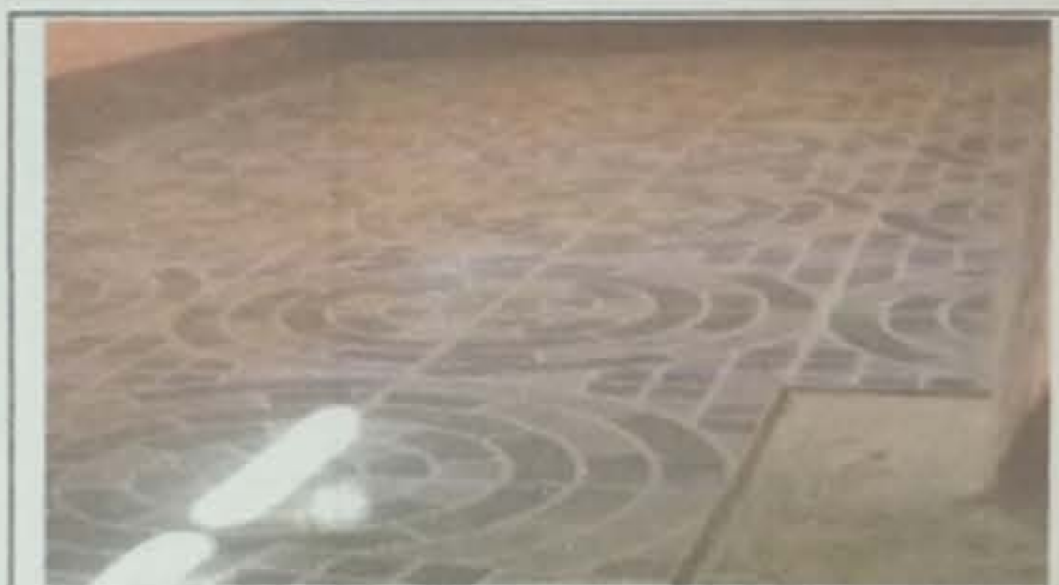
Modulo 1 Foto 4: Sustitución de piso cerámico
