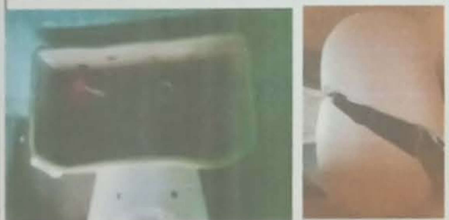
Modulo 2 Foto 5: Sustitución de accesorios inodoro (contra llave, tubo de abasto y tanque) Sustitución de tapadera sanitario
