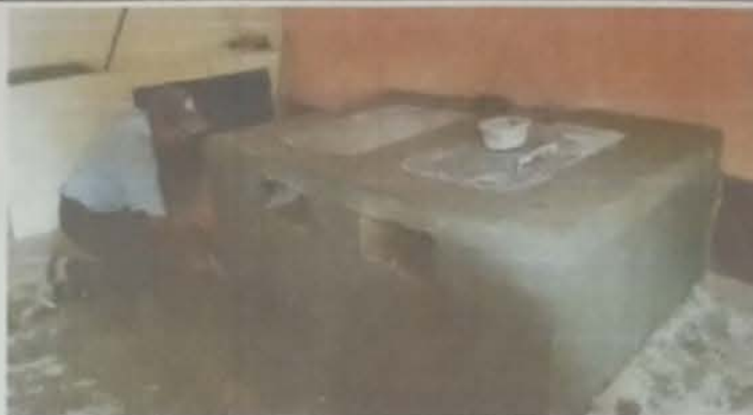
Modulo 1 Foto 2: Sustitución de estufa rural (completa) incluye chimenea y plancha de metal
