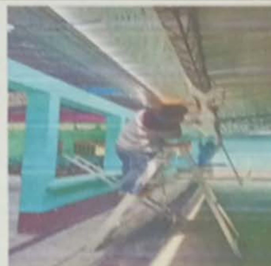
MODULO 3 sustitución de canal de metal
