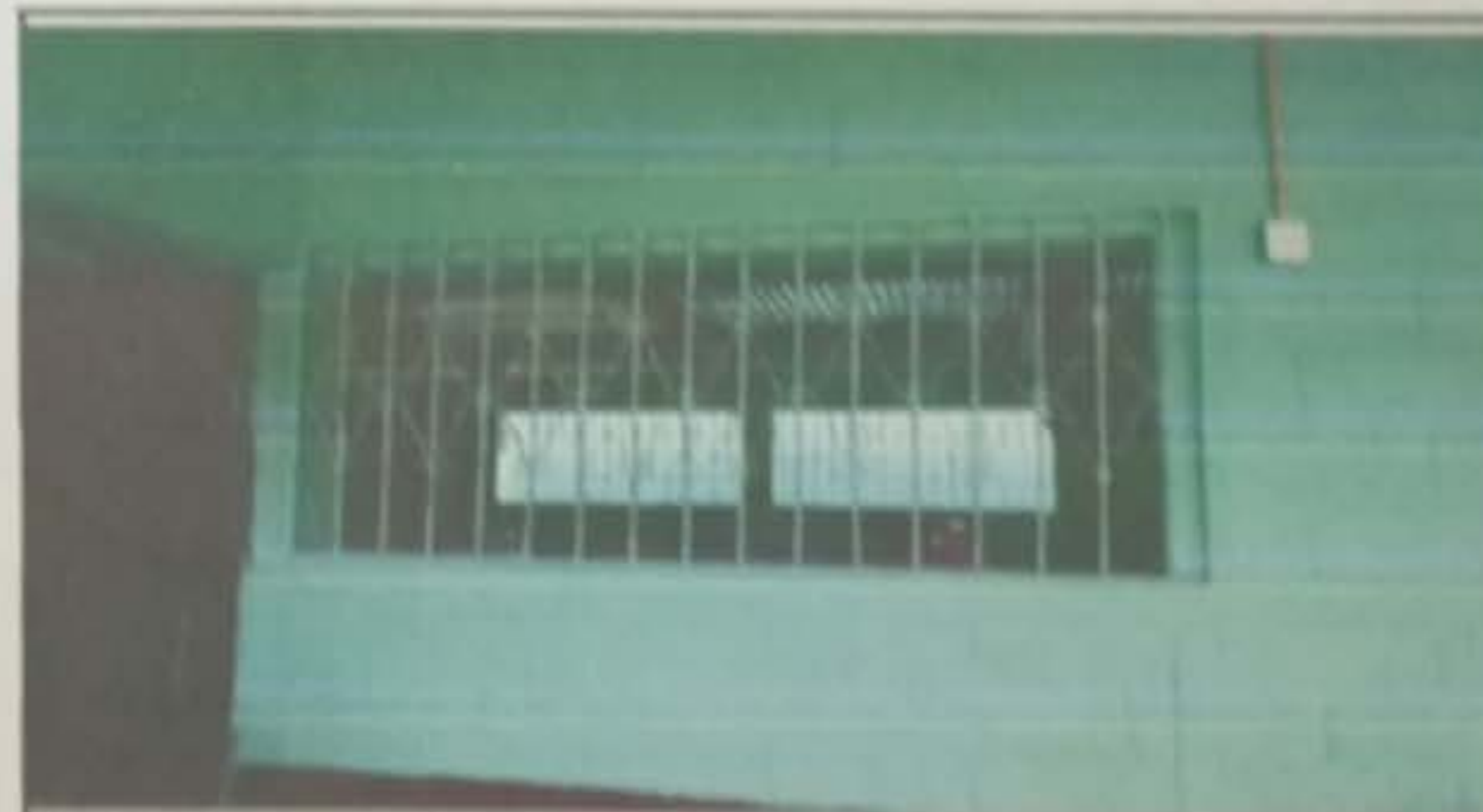
MODULO 4 Sustitución de ventanas
