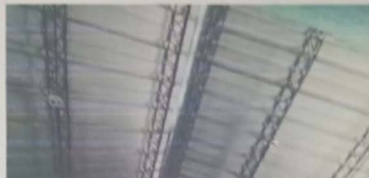
MODULO 2 Sustitución de focos ahorradores
