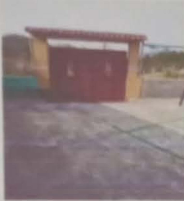
MODULO 4 Reparacion de porton de metal
