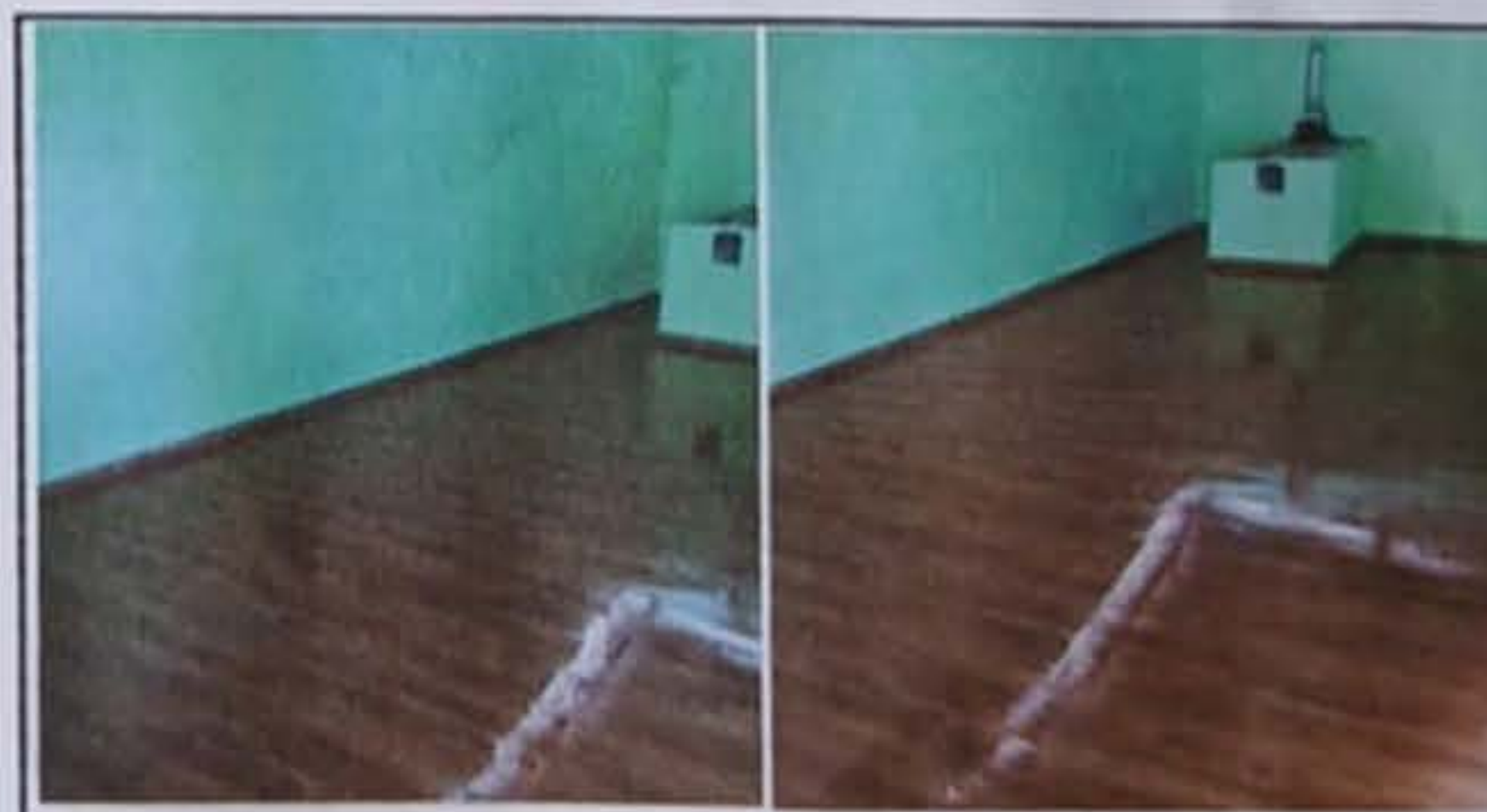
Foto 6: sustitucion de piso a ceramica
