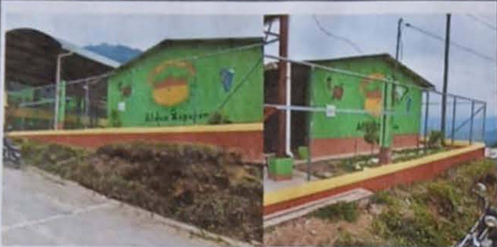
Foto 1: sustitucion de malla
