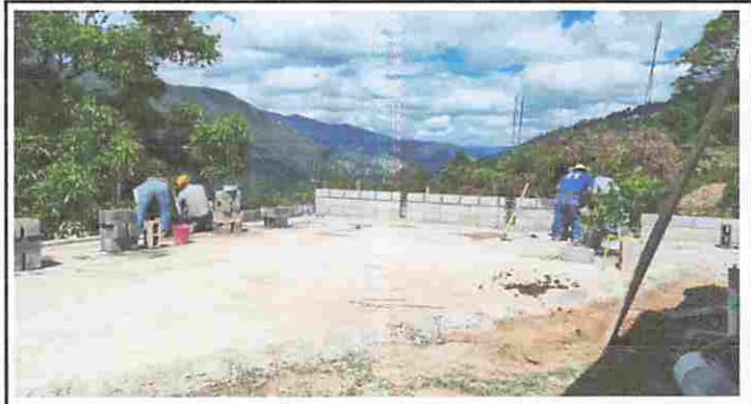
Modulo 15: Reparación de muro Perimetral Block con tubo hg, y Malla Galvanizada, soleras intermedias y columnas.
