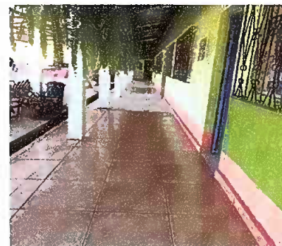
Foto 4: MODULO II: SUSTITUCION DE TORTA DE CONCRETO POR PISO CERAMICO
