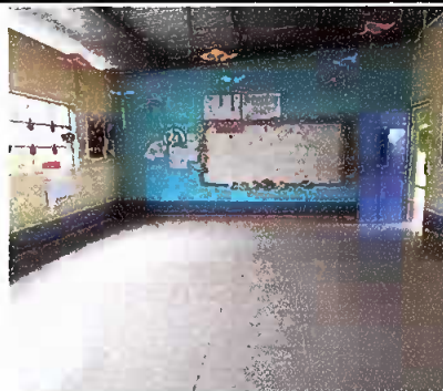
Foto 2: MODULO I: SUSTITUCION DE TORTA DE CONCRETO POR PISO CERAMICO
