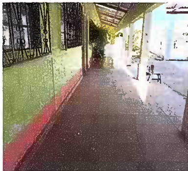
Foto 3: MODULO II: SUSTITUCION DE TORTA DE CONCRETO POR PISO CERAMICO
