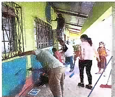
Foto 5: MODULO III: PINTURA EN MUROS EXTERIORES
