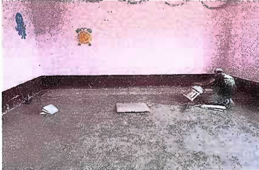
Foto1: MODULO I: SUSTITUCION DE TORTA DE CONCRETO POR PISO CERAMICO
