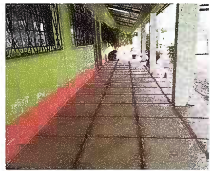
Foto 4: MODULO II: SUSTITUCION DE TORTA DE CONCRETO POR PISO CERAMICO
