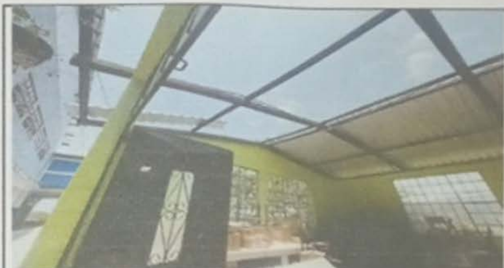
Foto 4: Módulo 2, instalación de lámina troquelada aluzinc calibre 26 y capote de lámina para lámina troquelada.
