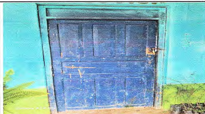
Foto 3. Modulo 1: Sustitución de puertas.
