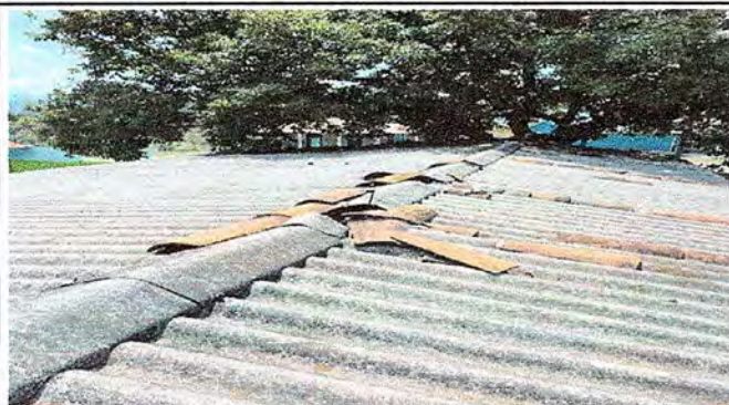
Foto 1. Modulo 1: Sustitución de Lámina.
