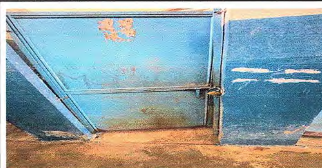
Foto 5. Modulo 2: sustitución de puertas.
