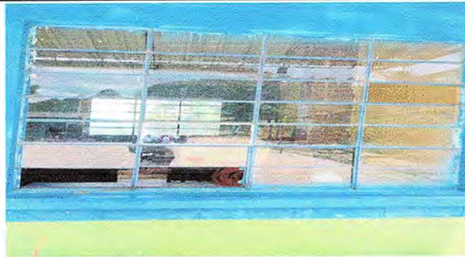
Foto 7. Modulo 4: Fabricación e instalación de balcones .
