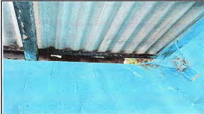
Foto 2. Modulo 1: Sustitución de estructura de soporte de madera por metal y sustitución de elementos de fijación.
