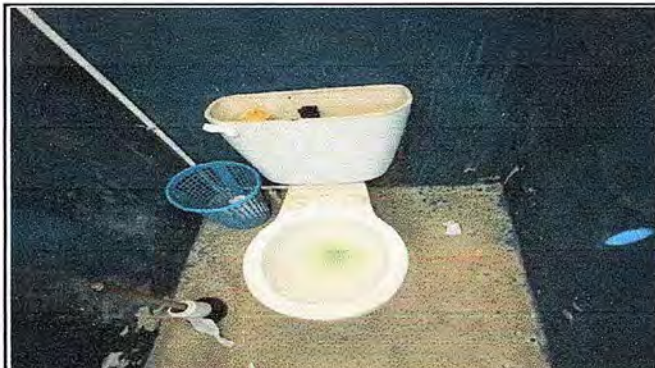
Foto 4. Modulo 2: Sustitución de inodoros.
