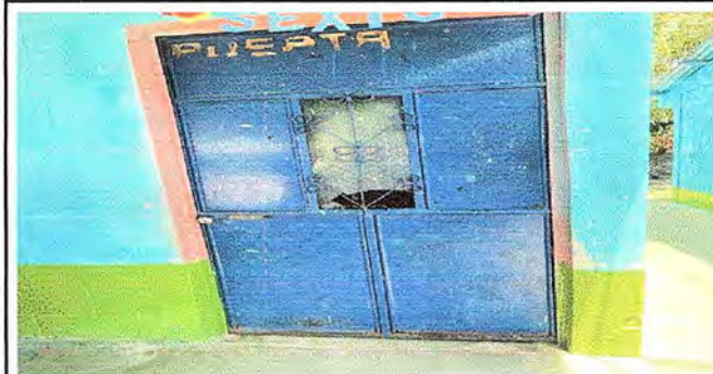
Foto 6. Modulo 3 : Sustitución de puerta.
